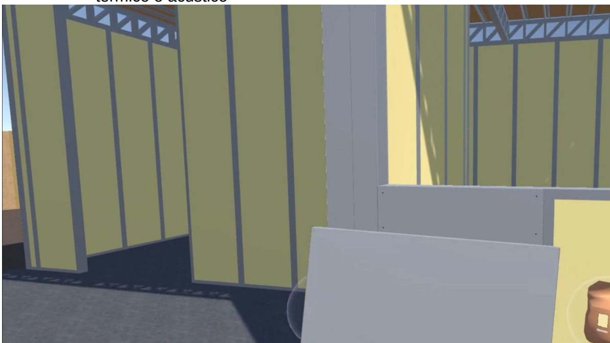
Figura 159 – Aluno 4 instalando as chapas cimentícias após a manta de isolamento térmico e acústico
