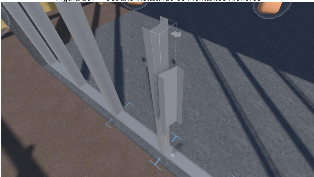
Figura 107 – Usuário instalando os montantes menores
