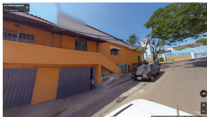
Rua Piedade do Paraopeba, 221 Local onde funcionou durante 1 ano o Pré-escolar do Bairro Santa Efigênia.
