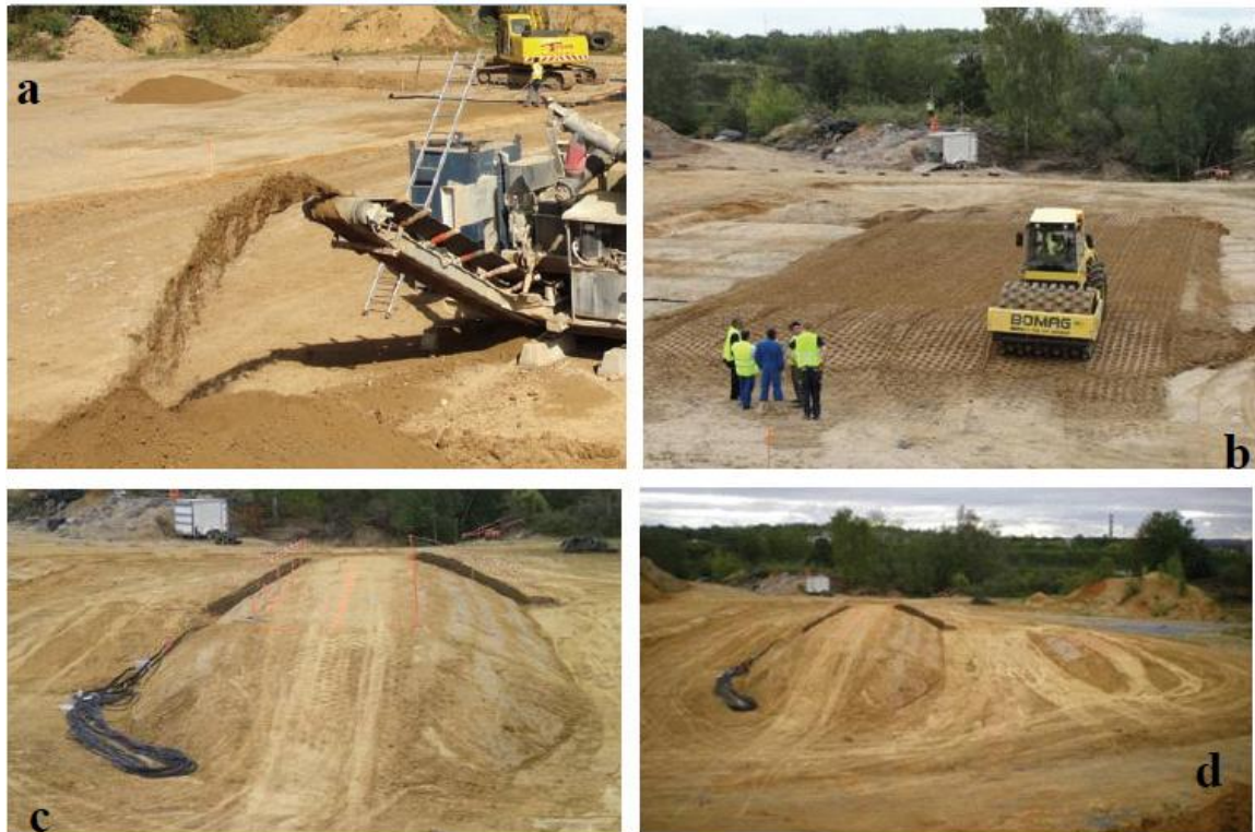
Figura 3.21: (a) Construção de um dique experimental com material tratado com cal, (b) aplicação e compactação com um rolo pé de carneiro, (c) visão geral do dique tratado com cal e (d) visão geral dos dois diques (tratado com cal e não tratado, à direita) (Herrier et al. , 2014).
