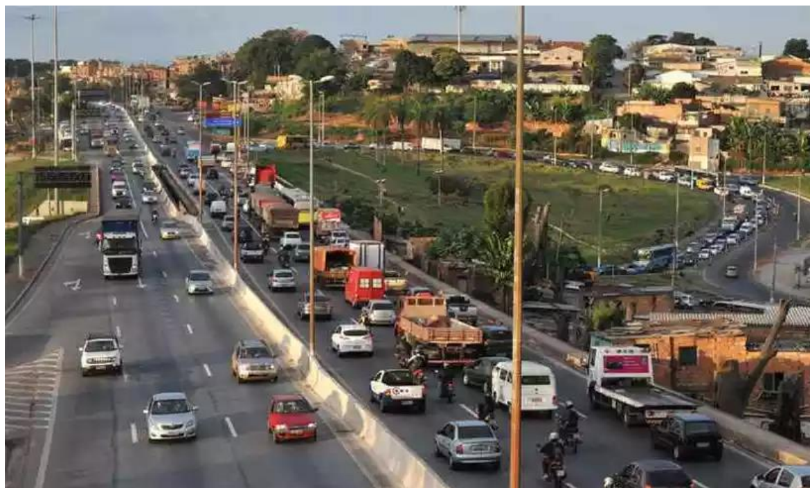
FIGURA 4.10 – Estreitamento de pista no Viaduto São Francisco, Anel Rodoviário.
