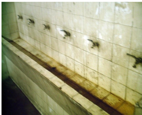
Figura 6. 6 - Pia do vestiário
