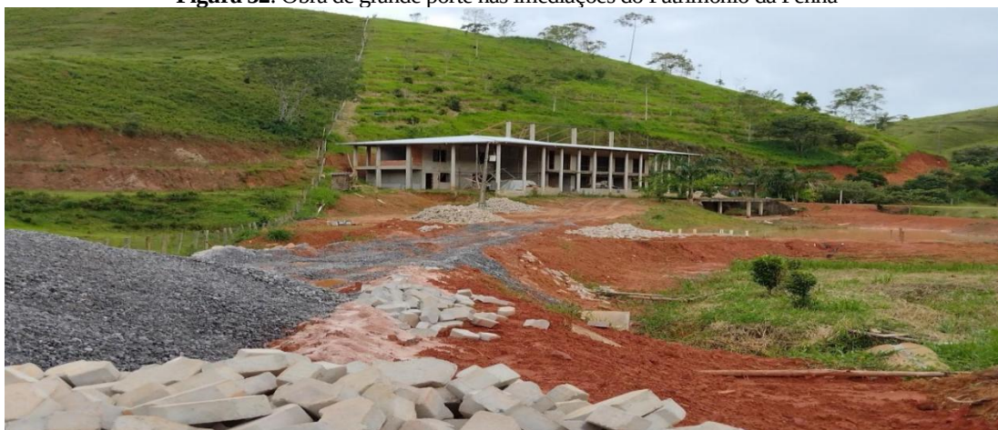
Figura 32: Obra de grande porte nas imediações do Patrimônio da Penha
