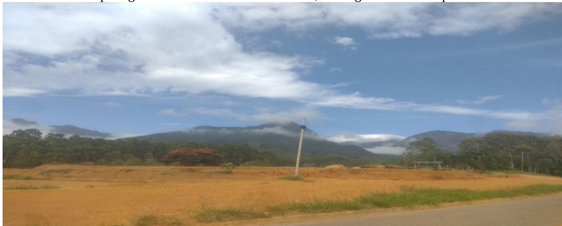
Figura 24: Área de terraplanagem entre Santa Marta e Pedra Roxa, às margens da rodovia que circunda o ParNa Caparaó
