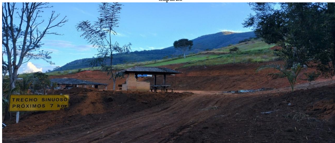
Figura 27: Área de terraplanagem na comunidade Paraíso, a poucos metros da portaria de Pedra Menina do ParNa Caparaó
