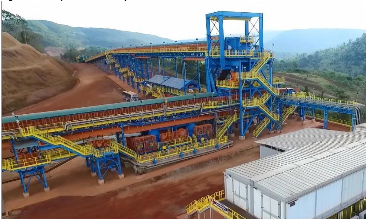
Figura 3: Exemplo de dois transportadores de correia e uma casa de transferência.
