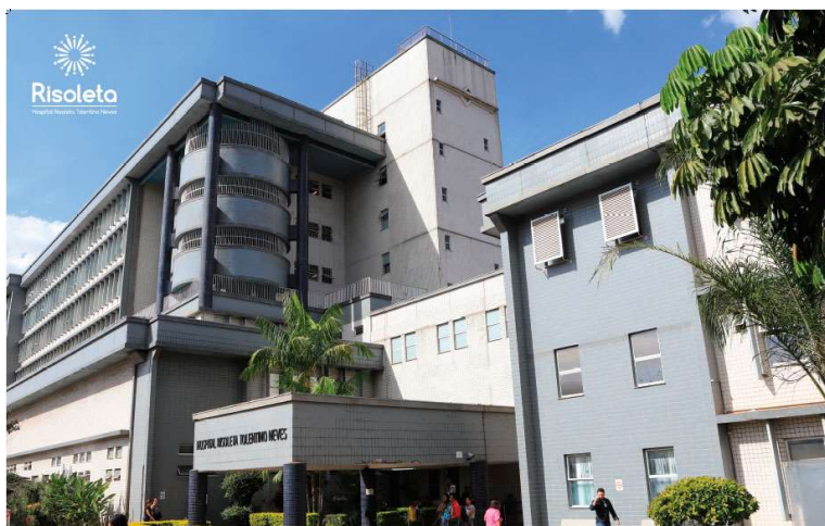
Figura 5 - Fachada do Hospital Risoleta Tolentino Neves, Belo Horizonte, Minas Gerais
