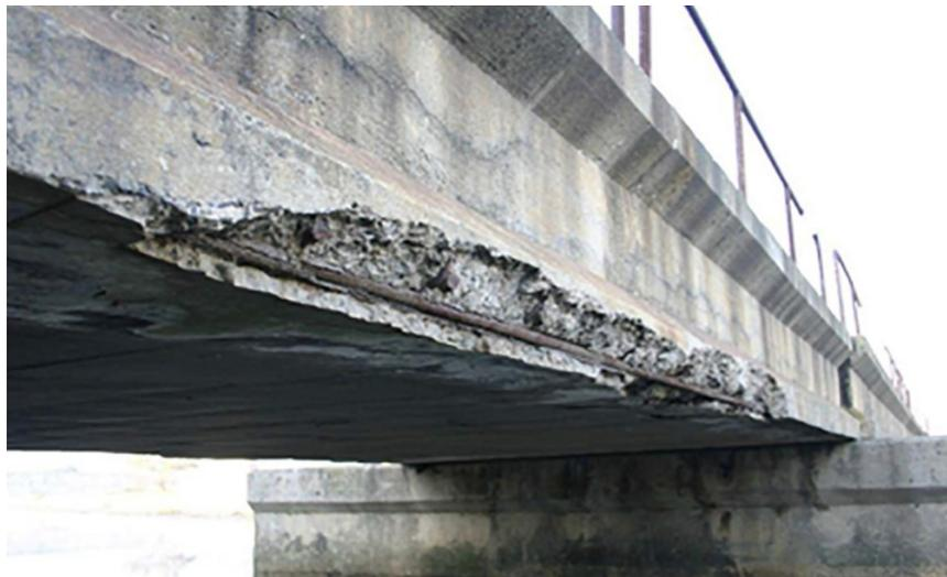
Figura 2.4 - Deterioração causada por corrosão em ponte na Cidade do Cabo
