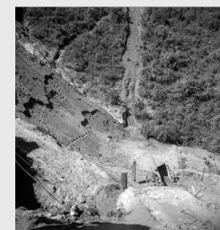
ÓRREGO DO LEITÃO – S/D ANALIZAÇÃO DO CÓRREGO DO LEITÃO. PCBH/ASCOM
