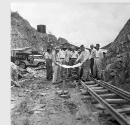
VISITA DOS ENGENHEIROS AS OBRAS DE CAPTAÇÃO DO RIO DAS VELHAS – S/D APCBH/ASCOM
