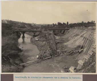
CANALIZAÇÃO DO ARRUDAS NO CRUZAMENTO COM A AVENIDA DO CONTORNO, ENTRE 1926-1930. FUNDO OM, APM
