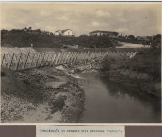
CANALIZAÇÃO DO ARRUDAS NO CRUZAMENTO COM A AVENIDA DO CONTORNO, ENTRE 1926-1930. FUNDO OM, APM
