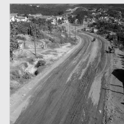
AV. HAVAI SERVIÇO DE TERRAPLANAGEM – S/D. OBRAS DE TERRAPLANAGEM NA AVENIDA HAVAI. APCBH/ASCOM
