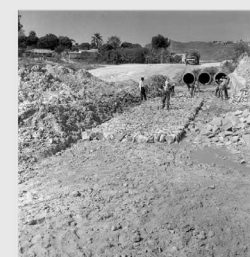
OBRAS – S/D OBRA DE CANALIZAÇÃO, RUA PROFESSOR MORAES. APCBH/ASCOM
