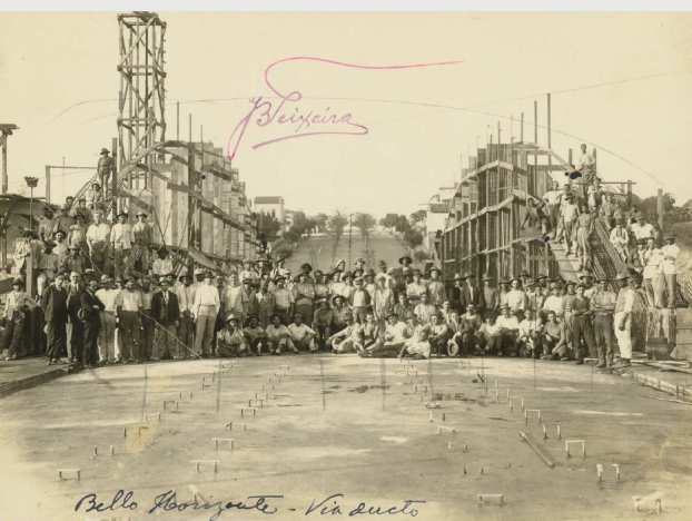
CONSTRUÇÃO DO VIADUTO DE SANTA TEREZA, 1928 ACERVO ICONOGRÁFICO JOÃO DE ALMEIDA FERBER ARQUIVO PÚBLICO MINEIRO
