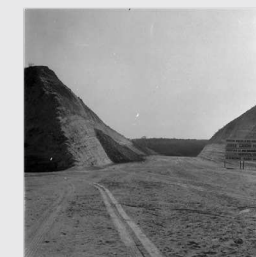
OBRAS – S/D ABERTURA DA AVENIDA SABARÁ. GESTÃO JORGE CARONE. APCBH/ASCOM
