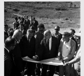
PREFEITO VISITA DIVERSAS OBRAS – 07/1968. PREFEITO, SOUSA LIMA VISITA OBRAS. APCBH/ASCOM
