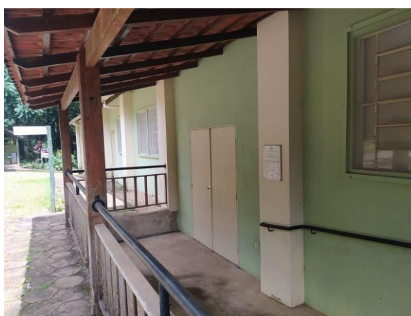
Figura 7: Vista lateral da atual da Reserva Técnica Temporária (RTT), antiga Sala de Exposição 3 (RE3).
