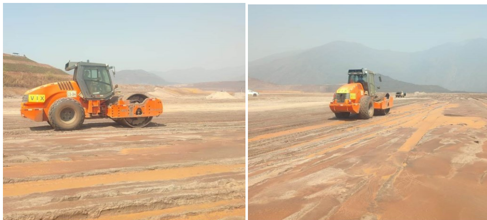
Figura 5.5 : Compactação com rolo compactador Hamm 3520_20 t
