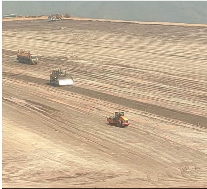
Figura 5.4 : Compactação com trator de esteira e rolo compactador
