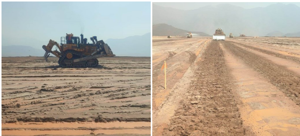
Figura 5.7 : Compactação com trator de esteira CAT D10T
