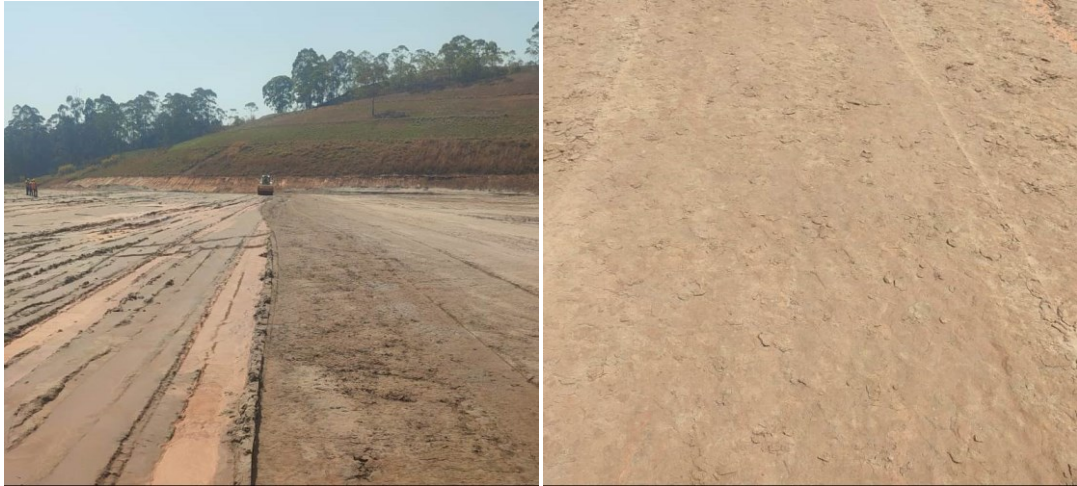
Figura 5.6 : Compactação com rolo compactador: Acabamento da praça
