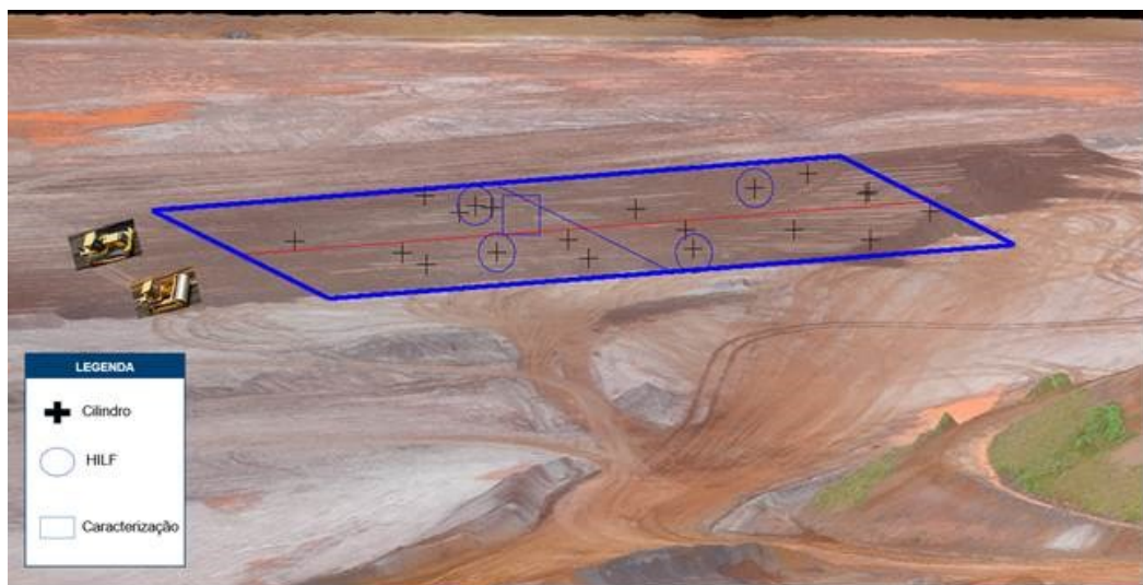
Figura 5.15 : Vista panorâmica lateral da área de teste PDRE Sul
