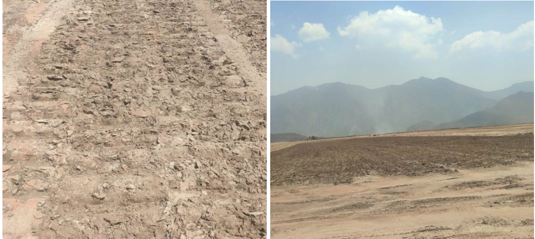
Figura 5.8 : Compactação com trator de esteira: Acabamento da praça
