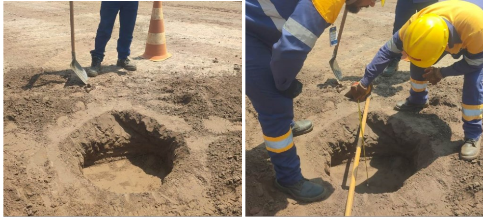
Figura 5.12 : Abertura de local para amostragem
