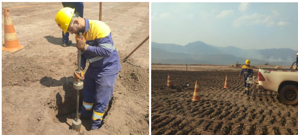
Figura 5.13 : Cravação do cilindro e medição
