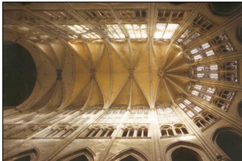
Figura 8: Teto da Catedral de Beauvais (iniciada em 1284). Detalhe das abóbadas em cruzaria (PRINA; DEMARTINI, 2005: 81).
