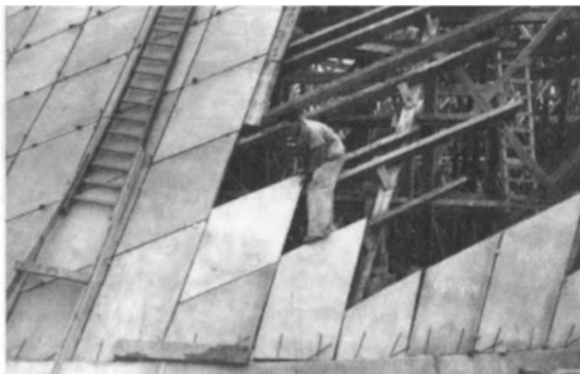
Figura 26 – Detalhe para as placas de concreto pré-moldadas do Pavilhão, presas por cabos de aço (XENAKIS; KANACH, 2008: 97)
