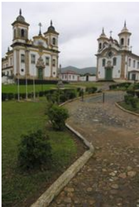
Figura 27 Antes da intervenção
