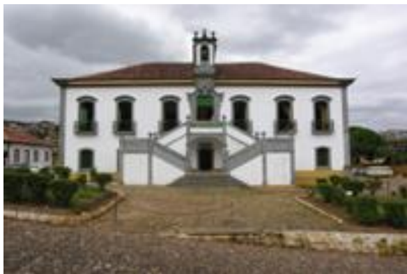
Figura 25 Câmara antes da intervenção
