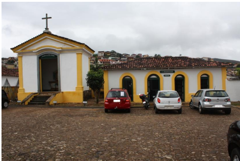
Figura 36 Construções na parte posterior da Câmara – Capela e Armazém Foto da autora, 2011
