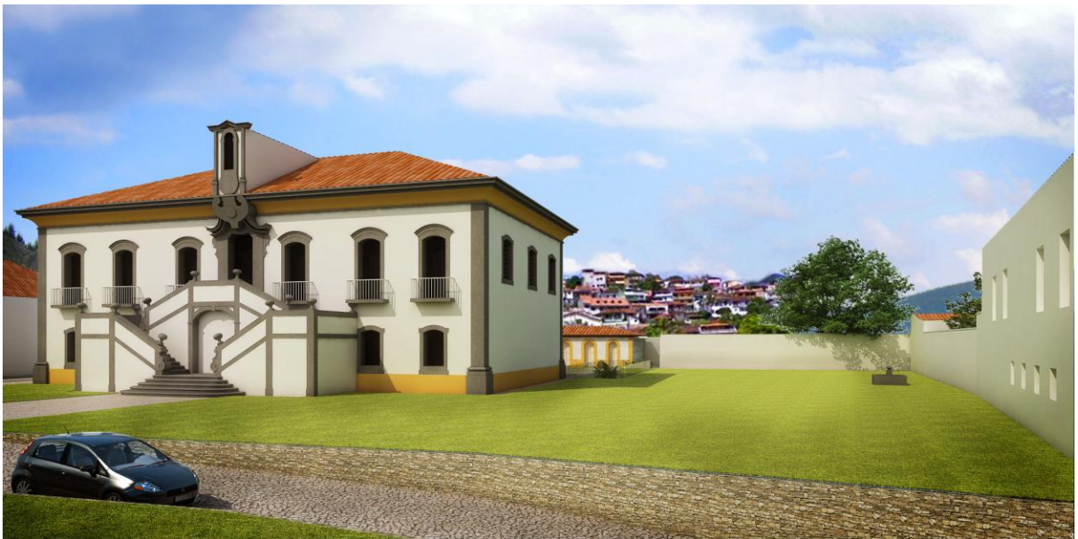
Figura 43 Fachada Principal da Câmara Municipal de Mariana com o 1º pavimento do Anexo ao fundo
