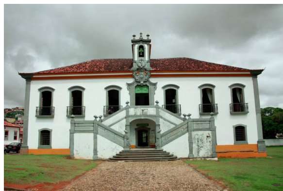
Figura 26 Câmara após a intervenção
