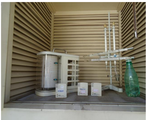
Figura 54: Localização dos data loggers no interior do abrigo meteorológico do 5°DISME/ INMET
