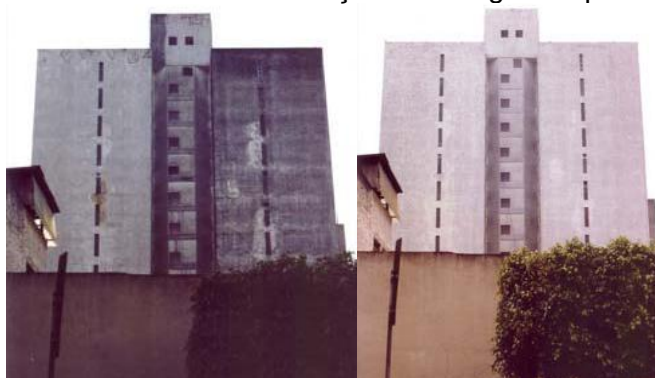
Figura 35 – Fachada com manifestações de fungos e após o tratamento.
