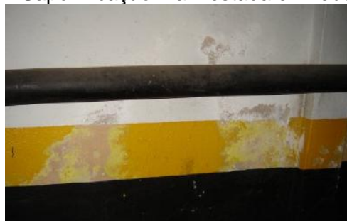
Figura 28 – Saponificação manifestada em reboco pintado.
