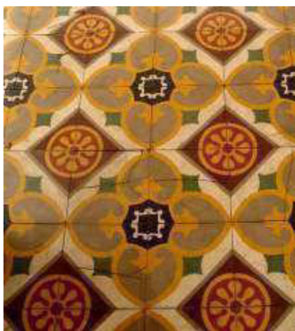
FIGURA 121 – LH da varanda de residência Av. Assis Chateaubriand, 194, (possivelmente, 1920).
