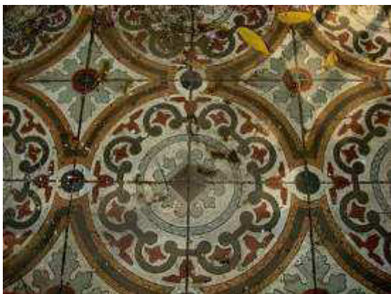
FIGURA 115 – LH da varanda de residência, Rua Cristovão Colombo, 336.
