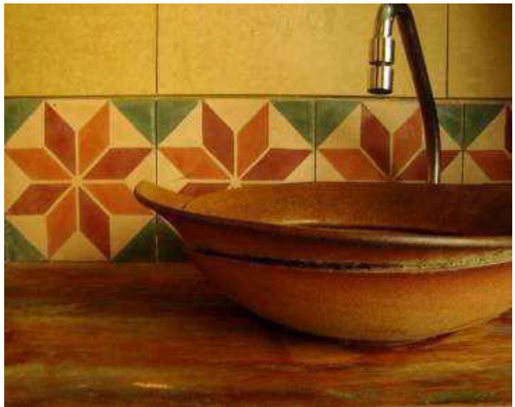
FIGURA 156 – Rodabanca de ladrilho em banheiro de restaurante. Rua Alagoas, 864.
