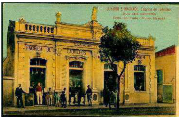
FIGURA 93 – Fachada da Fábrica de Ladrilho hidráulico Lunardi & Machado .
