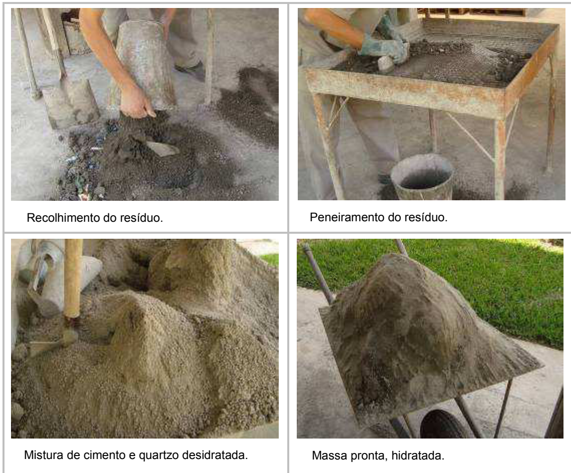
FIGURA 35 – Etapas do processo de manipulação da camada inferior.
