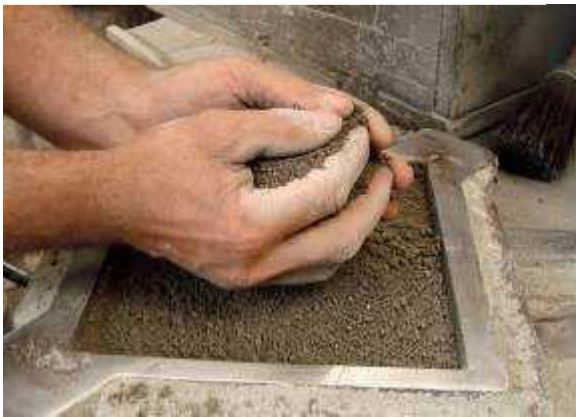
FIGURA 46 – Colocação da argamassa comum – camada inferior.
