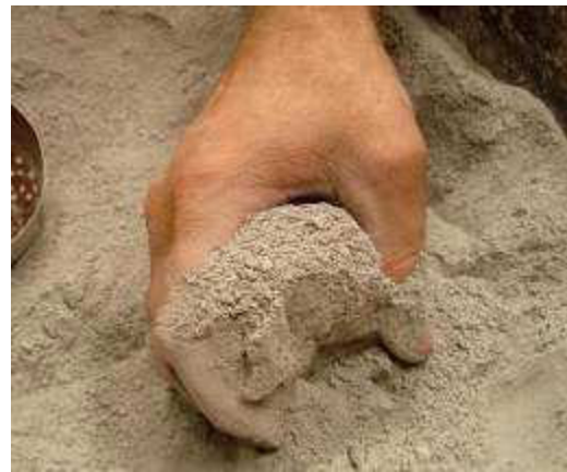
FIGURA 44 – Pega do secante para complementar a espessura da camada.
