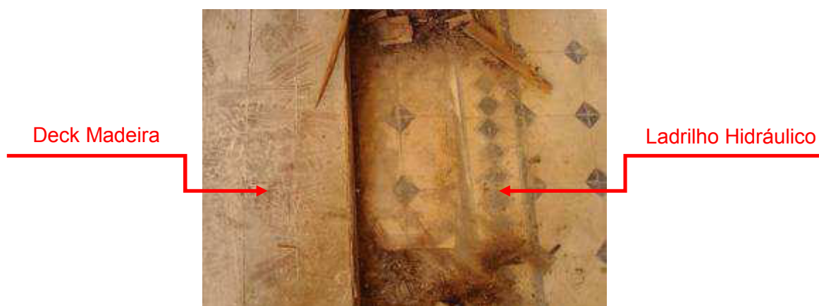
FIGURA 149 – LH coberto com piso de madeira. Secretaria do Interior e da Justiça, futuro CCBB, em restauração.
