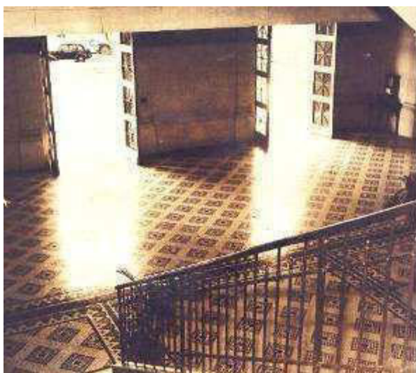
FIGURA 98 – Ladrilho hidráulico em edifício comercial em Belo Horizonte.
