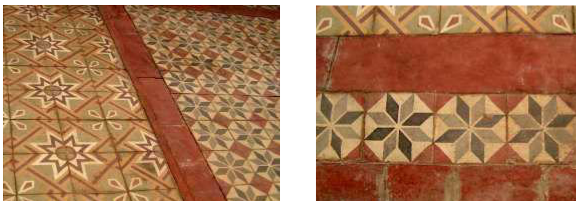
FIGURA 150 – Intervenções realizadas no piso de LH da antiga Secretaria da Agricultura.
