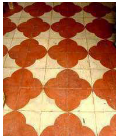
FIGURA 146 – LH no salão de restaurante, rua Aquiles lobo, 535, (1947).
