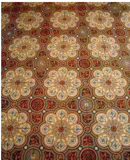
FIGURA 106 – Ladrilho hidráulico do Hall de acesso principal do Museu das Minas e do Metal.
