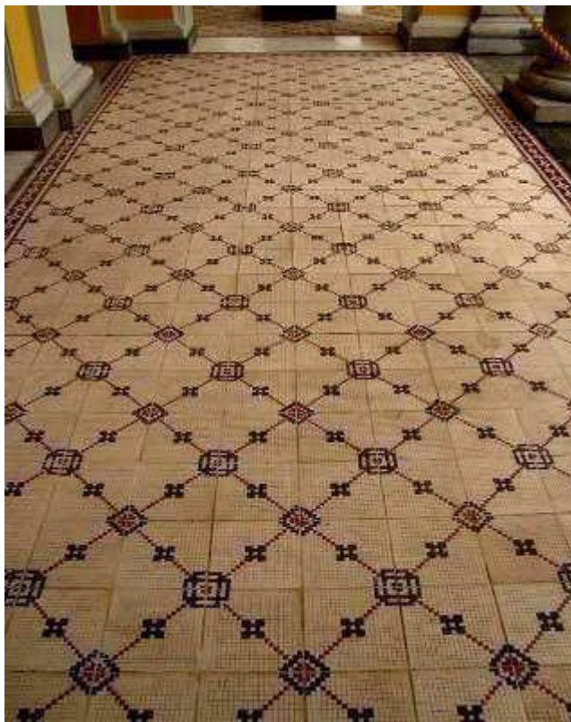
FIGURA 82 – LH dos corredores externos de acesso lateral e principal, Museu de Artes e Ofícios.
