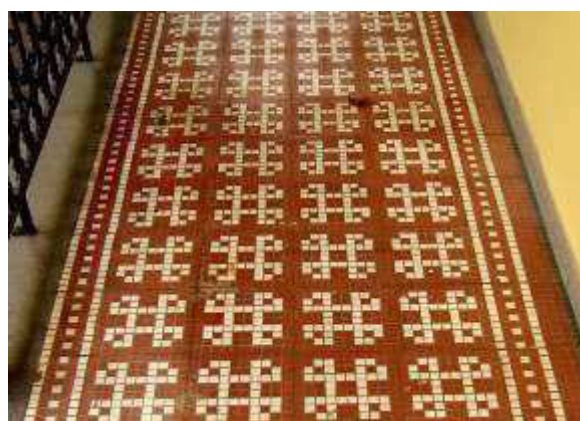
LH do corredor externo de varanda de residência. Rua Cláudio Manoel esq. rua Pernambuco. Acervo pessoal.
