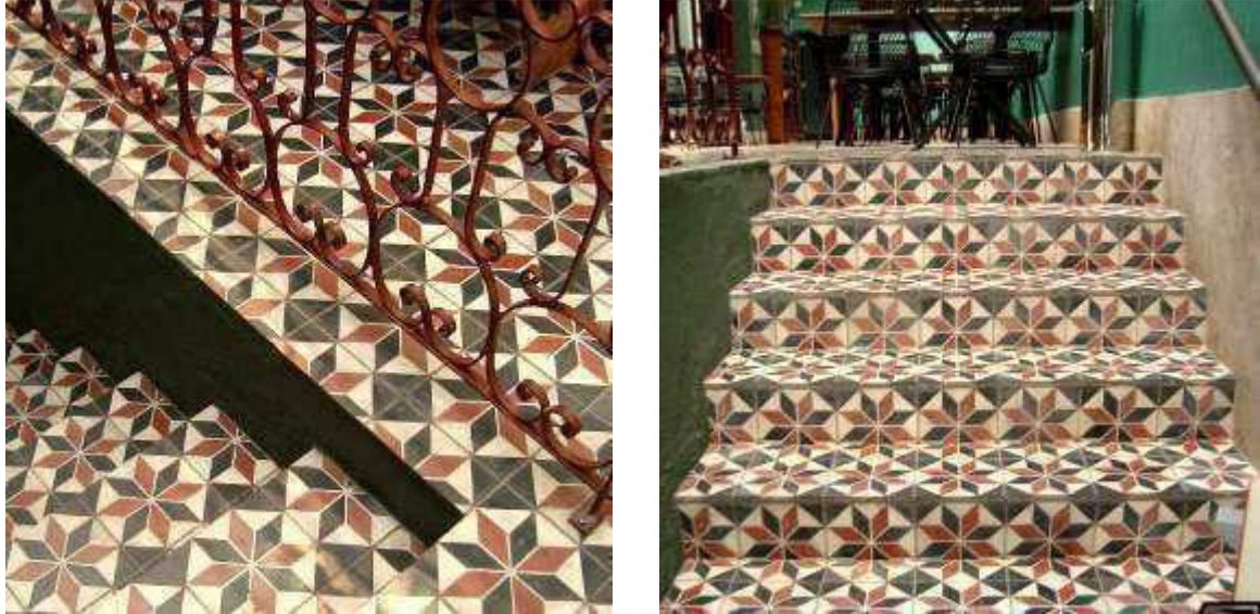
FIGURA 154 – Ladrilho hidráulico no piso e no espelho da escada do restaurante. Rua Cláudio Manoel, 583.
