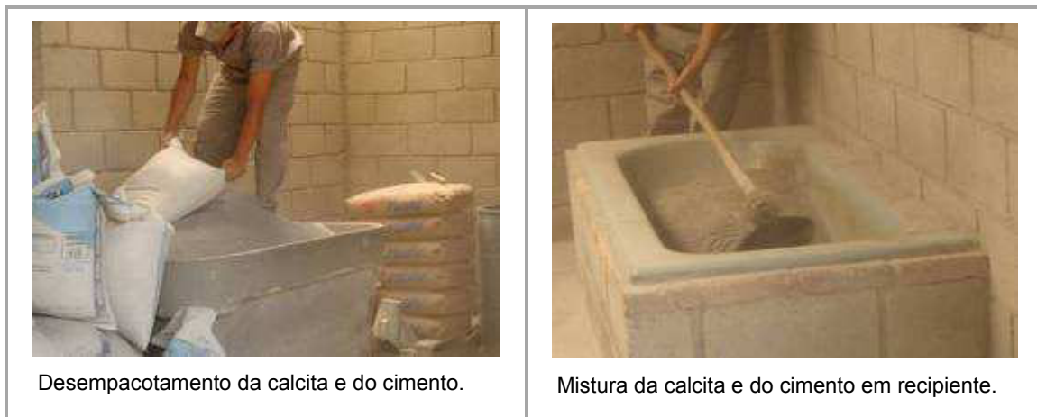
FIGURA 34 – Etapas do processo de manipulação da camada intermediária.
