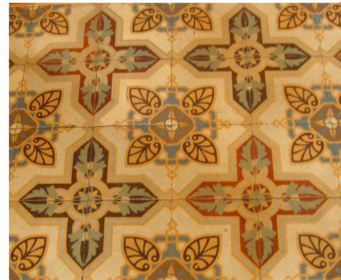
FIGURA 09 – Ladrilho hidráulico do hall de acesso do edifício Memorial Minas Gerais – Vale, (1897).
