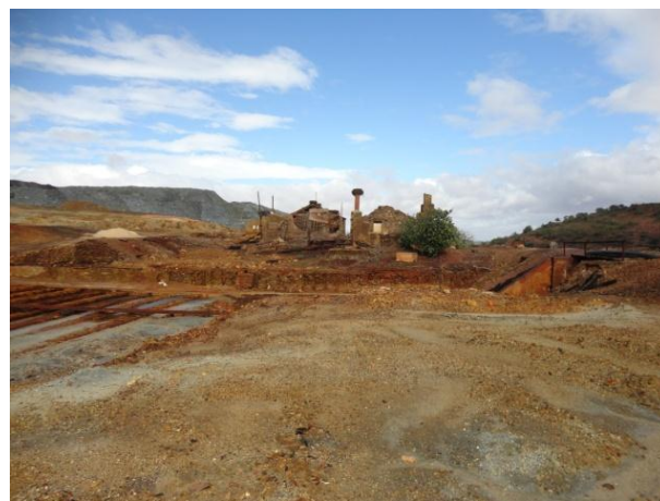
Figuras 13 - Antigas construções da mineração em Algares, com as pilhas de rejeito ao fundo
