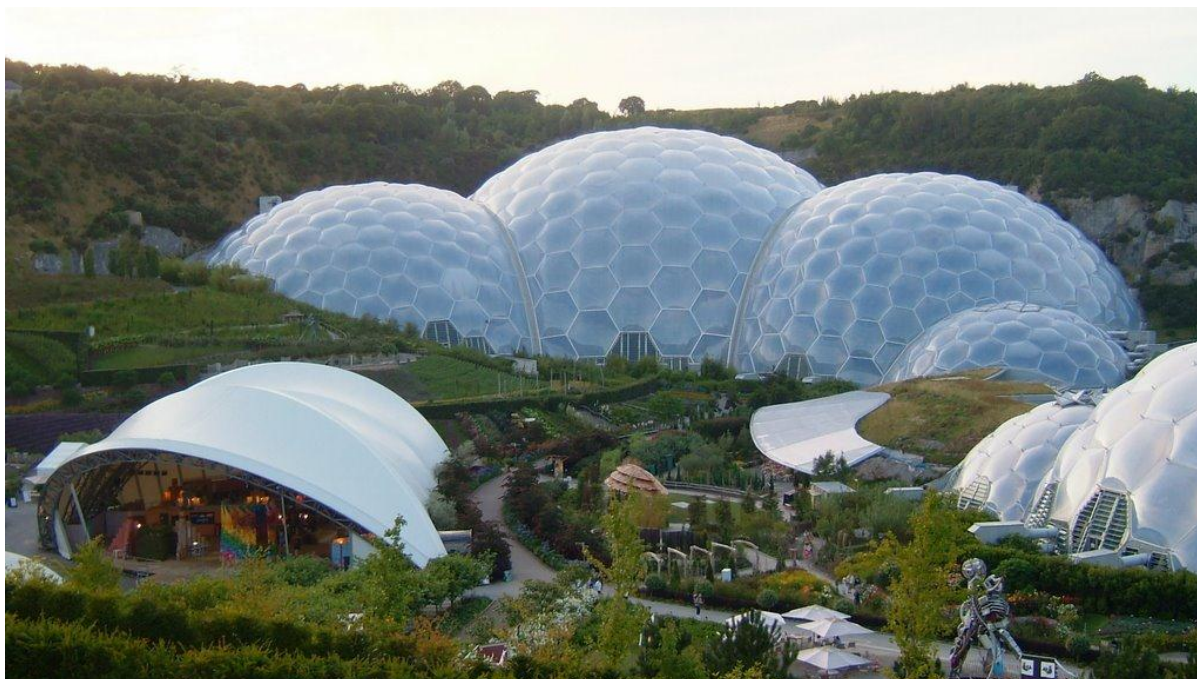
Figura 08 - [Vista da maior estufa do Eden Project]
