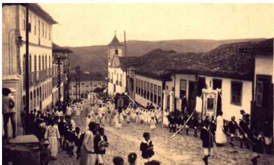
Figura 20: Rua Direita antes da demolição da Igreja Matriz de Santo Antonio. Fonte: (autor desconhecido)
