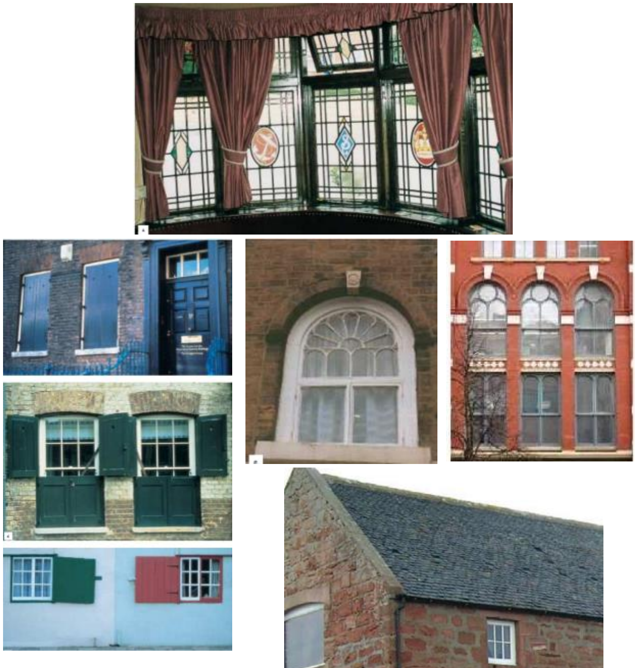
FIGURA – Exemplos de alguns dos diversos tipos de janelas existentes em edificações históricas.
