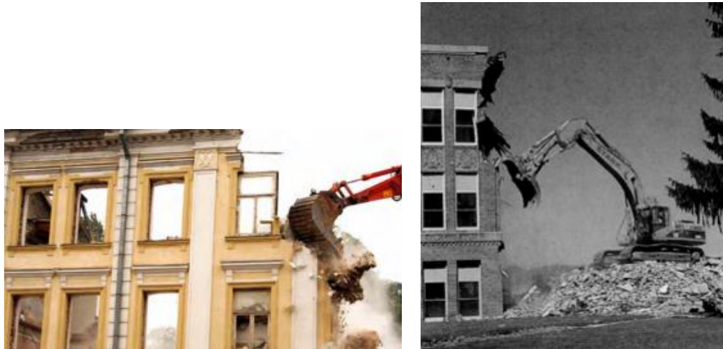
FIGURA - Demolição da Normal High School, Illinois, EUA 52 .
