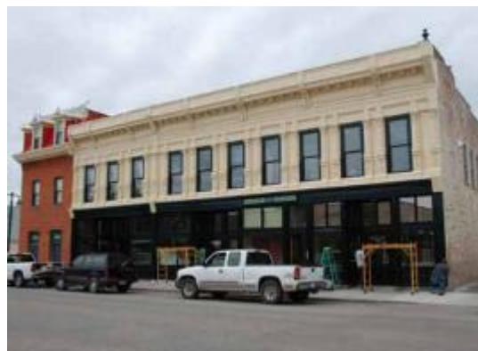
(b) Após a restauração das fachadas e preservação da fachada de metal forjado. Manutenção da pintura em andamento.
