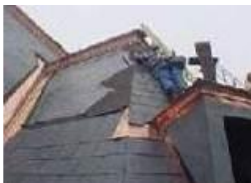
FIGURA – Reabilitação do Truro Post Office, na cidade de Truro, Canadá 90 .
