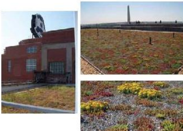
FIGURA – Emprego telhado verde.
