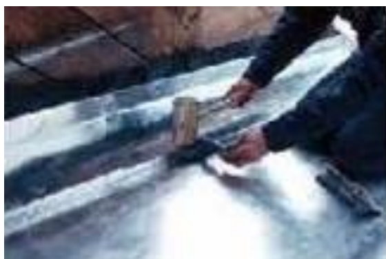
FIGURA – Restauração da antiga agência de correios da cidade de Dawson, Canadá 89 .
