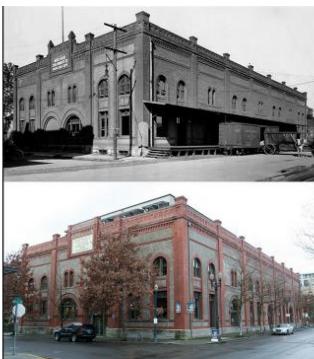
(a) Fachada antes e após do projeto de reutilização
