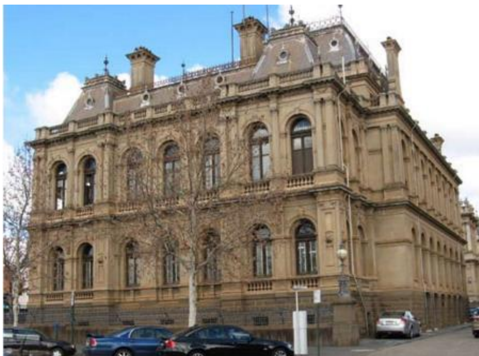
FIGURA – Bendigo Law Courts (DPCD), Austrália: exemplo de edificação histórica de alvenaria e pedra, com alta inércia térmica.
