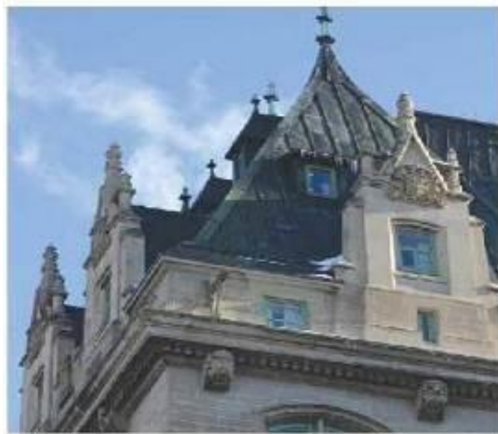
FIGURA - Telhado de cobre da Fort Garry Hotel em Winnipeg (Canada).
