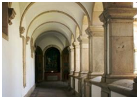
(b) Vista interna.
