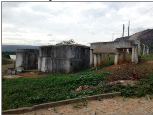
Figura 1. Estrutura inacabada da obra de construção de um sistema de esgotamento em SPJ.
