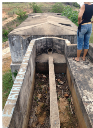
Figura 2. Estrutura inacabada da obra de construção de um sistema de esgotamento em SPJ.
