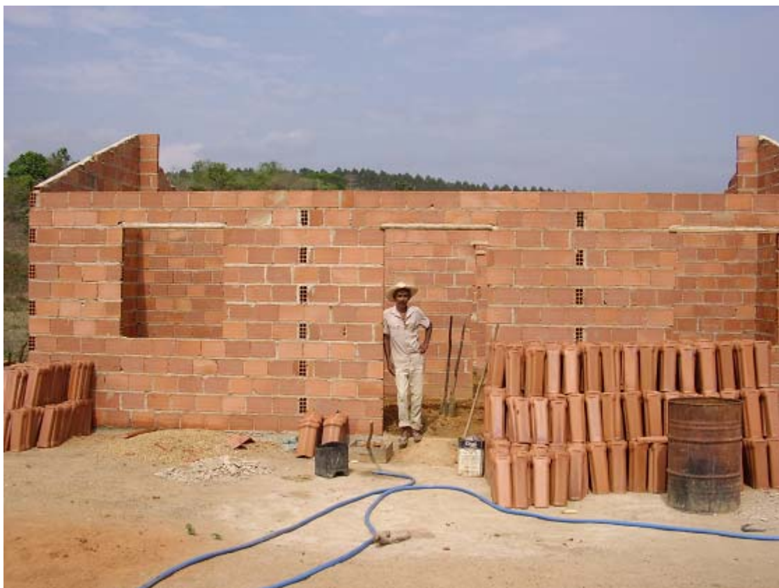
Figura 6. Construção da casa de um dos assentados com o crédito habitação em outubro de 2008.
