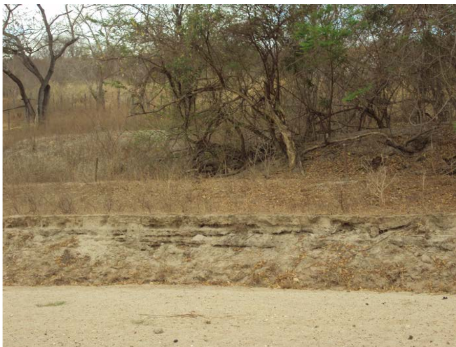
Figura 4.64 - Poços piezométricos rasos localizados na margem direita
