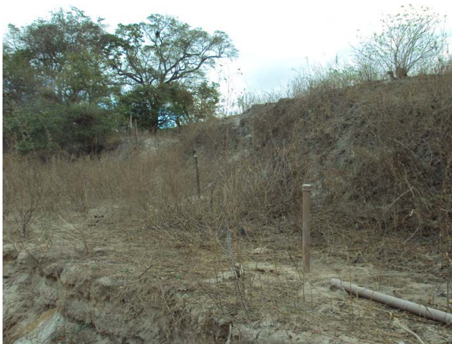
Figura 4.65 - Poços piezométricos rasos localizados na margem esquerda
