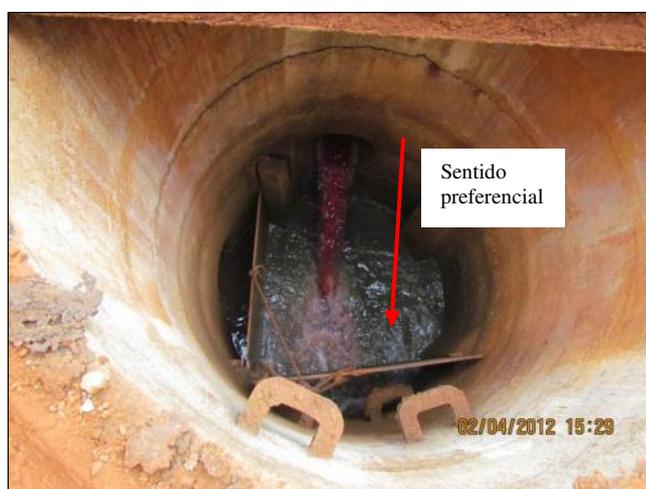
**Figura 5.69** - Chegada do corante no primeiro PV da lagoa facultativa e distribuição da vazão – ETE Confins.
