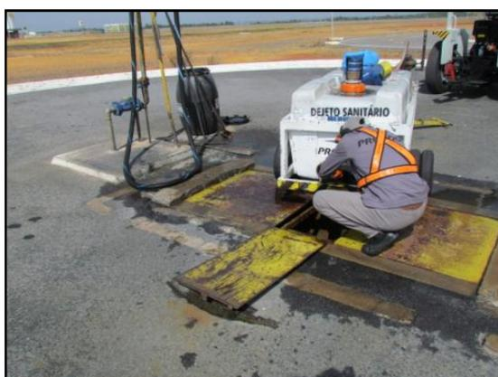
**Figura 4.8** - Operação de descarga do QTU (equipamento de coleta e transporte dos efluentes das aeronaves) na cloaca – Aeroporto Internacional Tancredo Neves – Confins - MG.
