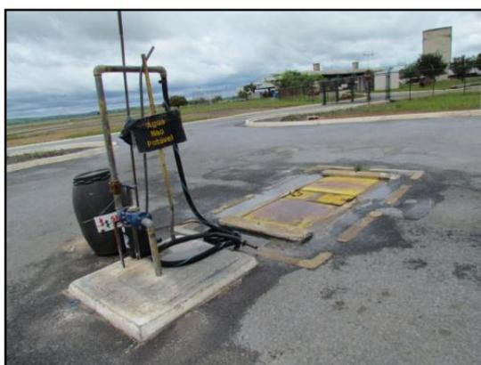
**Figura 4.7** – Vista da Cloaca (instalação presente nos aeroportos para recebimento dos efluentes sanitários das aeronaves) – Aeroporto Internacional Tancredo Neves – Confins - MG.
