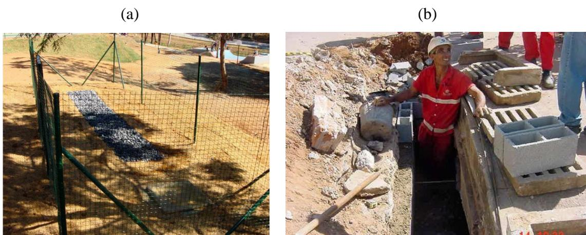
**Figura 3.15:** Experimentos desenvolvidos no projeto SWITCH (a) Trincheira de infiltração no Parque Nossa Senhora da Piedade (b) Construção de boca de lobo permeável no bairro Guaratã
