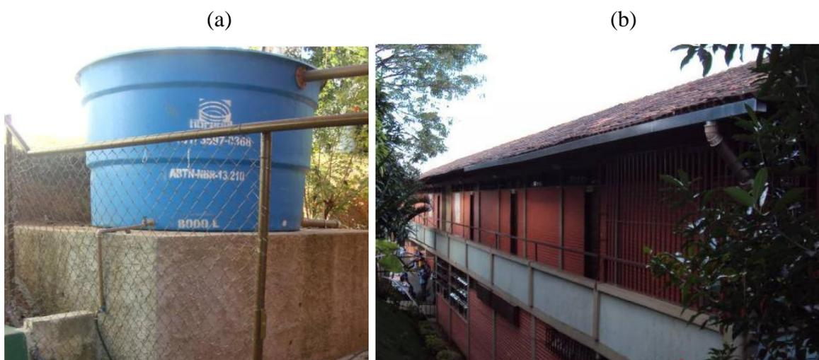
**Figura 3.16:** Aproveitamento de água pluvial na Escola Municipal Anne Frank (a) Reservatório de 8.000L (b) Calha metálica que coleta a água precipitada
