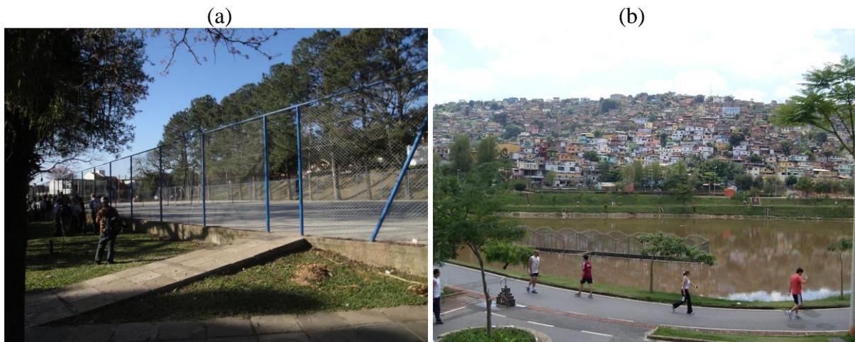
**Figura 3.5:** Estruturas centralizadas de controle de drenagem urbana (a) Bacia de detenção subterrânea com equipamento urbano (Porto Alegre, RS) (b) Bacia de detenção aberta com equipamentos públicos (Belo Horizonte, MG).
