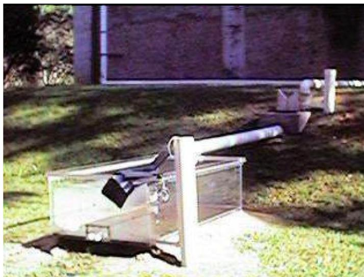
**Figura 3.26:** Microrreservatório instalado
