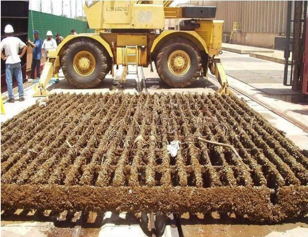
**Figura 18** – Infestação de grade da UHE Porto Primavera (Fonte: <http://www.maxpressnet.com.br/e/cesp/imagens/foto%2022.jpg>).
