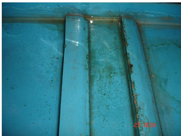
**Figura 25** – Soleiras no fundo do canal para controlar movimentação das grades.
