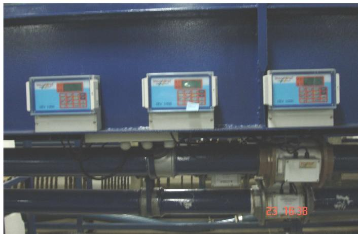
**Figura 36** – Medidores eletromagnéticos de vazão nas tubulações de adução do canal.
