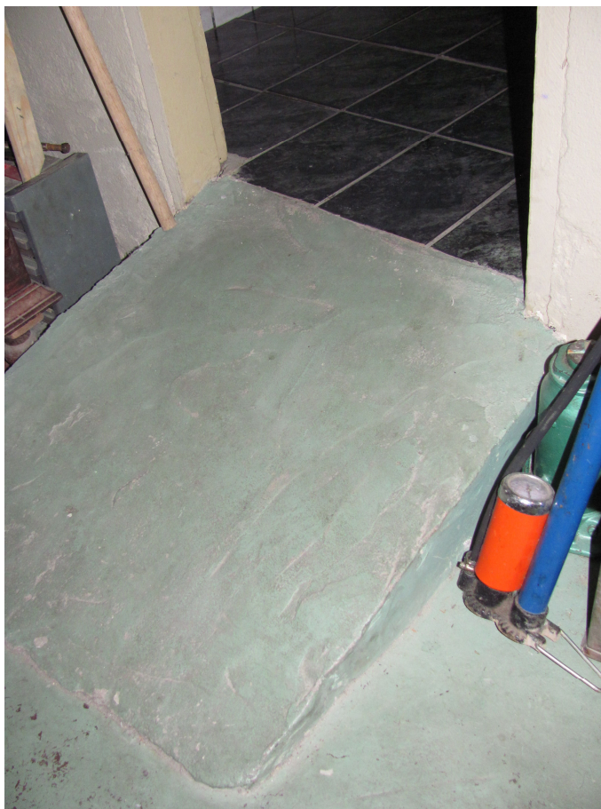
FOTO 76: Residência João - rampa para acesso ao banheiro.
