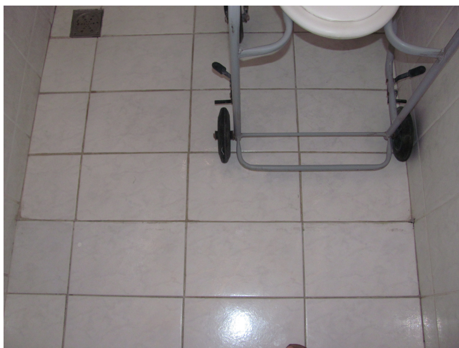
FOTO 44: Residência Rafael - detalhe da área de circulação do banheiro suíte.
