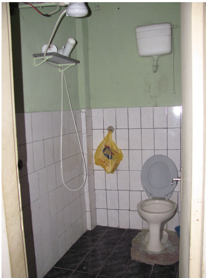
FOTO 75: Residência João - espaço interno do banheiro.
