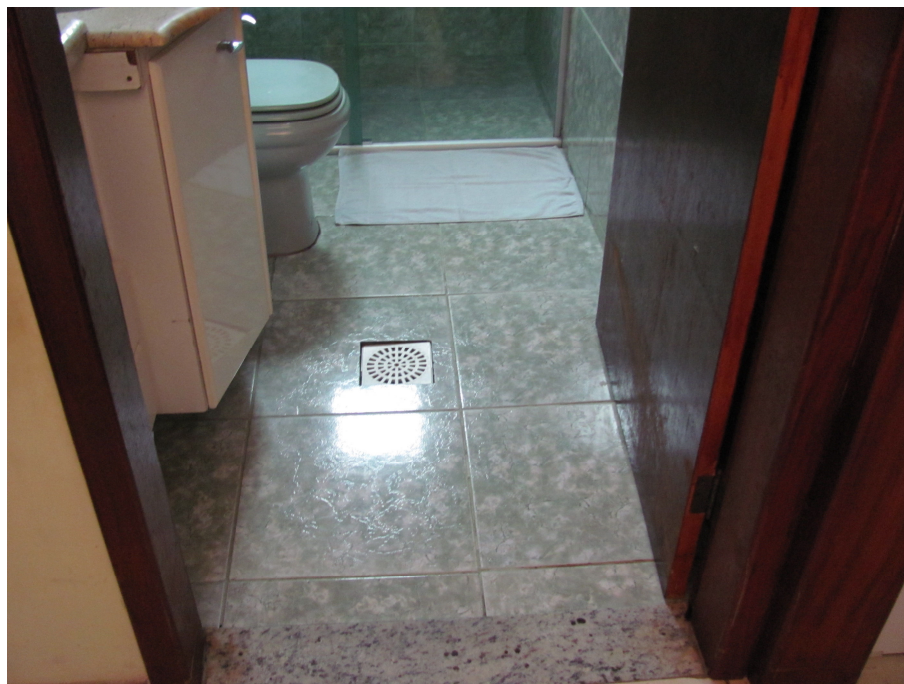
FOTO 47: Residência Lucas - detalhe da entrada do banheiro.
