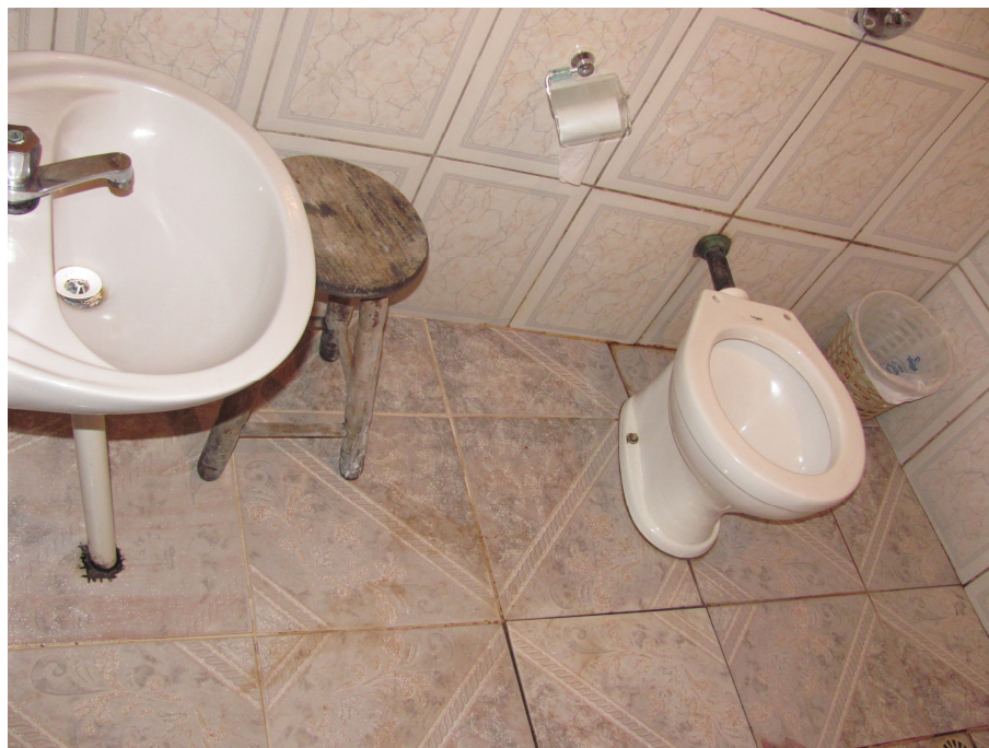
FOTO 69: Residência Leandro - espaço interno do banheiro.
