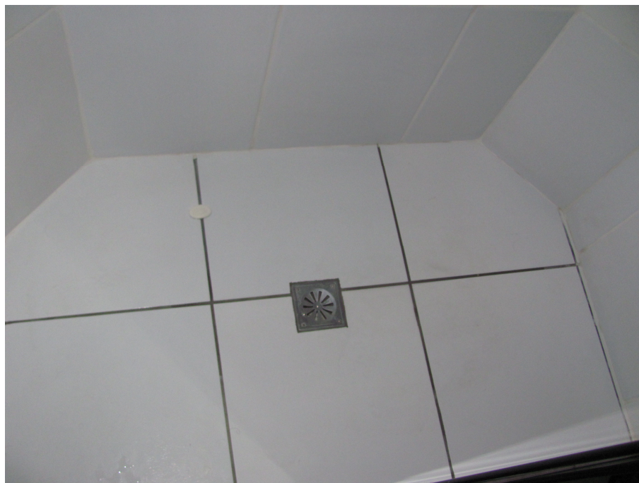
FOTO 82: Residência Luciano - espaço interno do boxe no banheiro.
