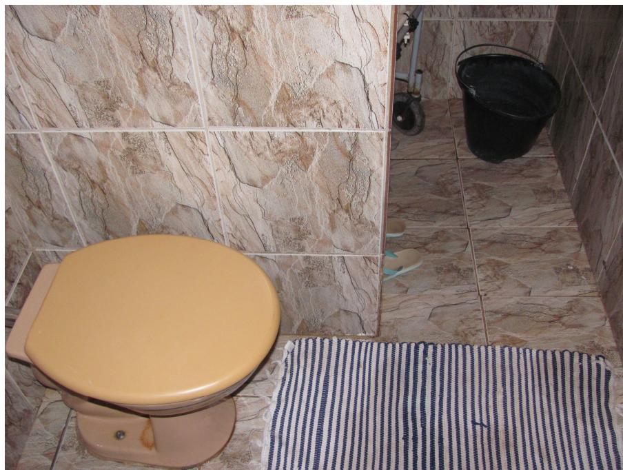
FOTO 120: Residência Pedro - detalhe da largura da porta do banheiro.
