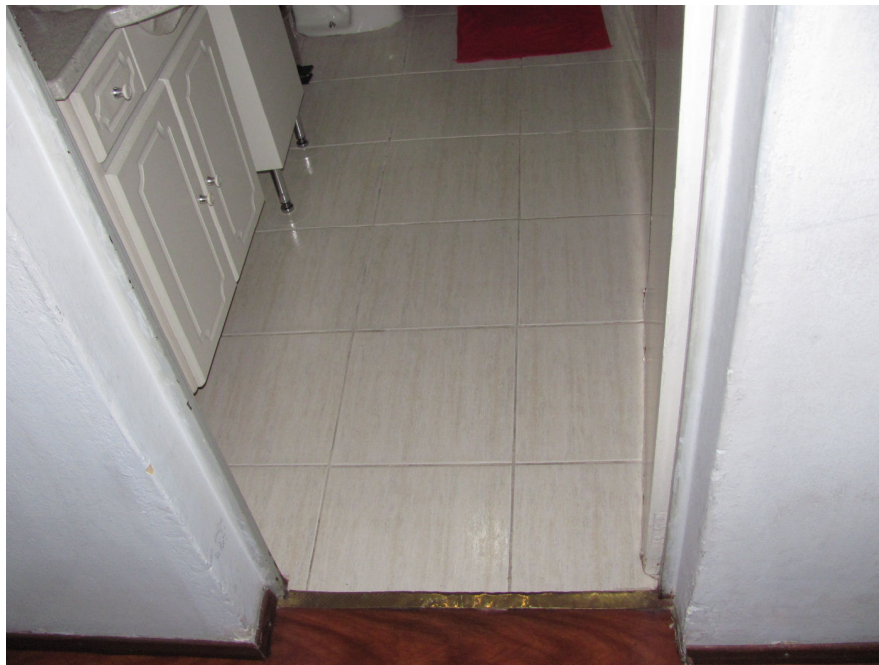
FOTO 19: Residência Fernando - acesso ao banheiro.
