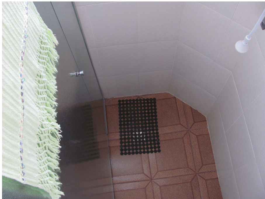
FOTO 107: Residência Raquel - vista superior do boxe do banheiro social - primeiro pavimento.
