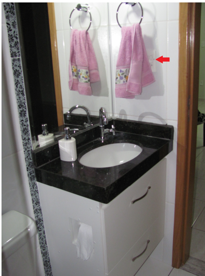
FOTO 85: Residência Luciano - detalhe da bolinha de silicone no interruptor do banheiro (indicado pela seta vermelha).
