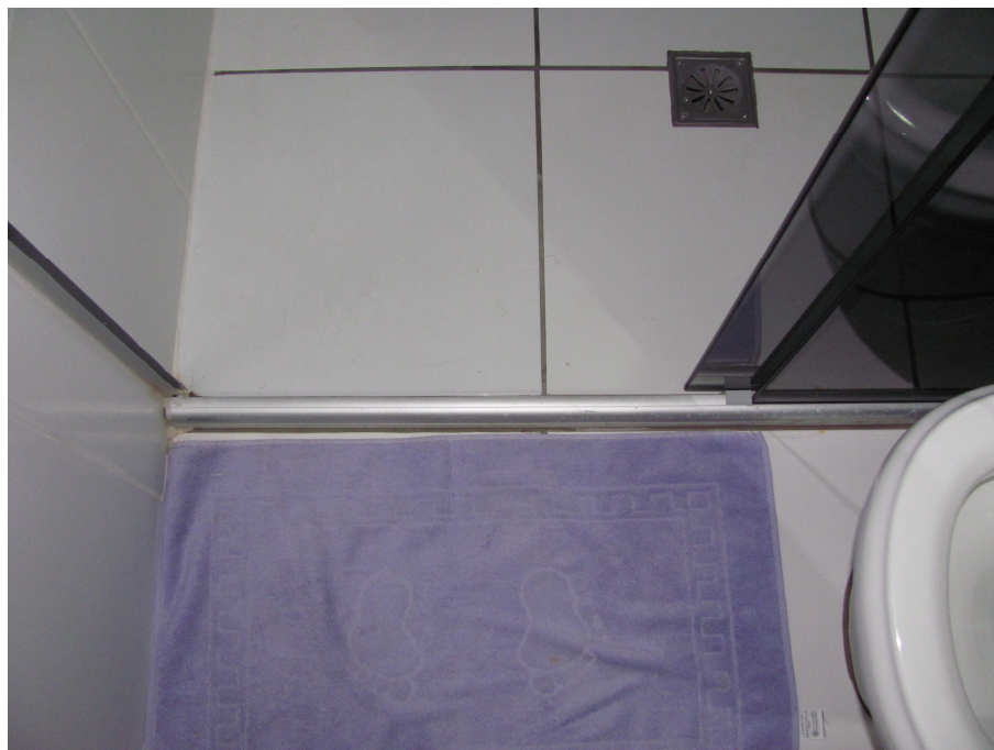
FOTO 83: Residência Luciano - divisão demarcada do boxe do banheiro.
