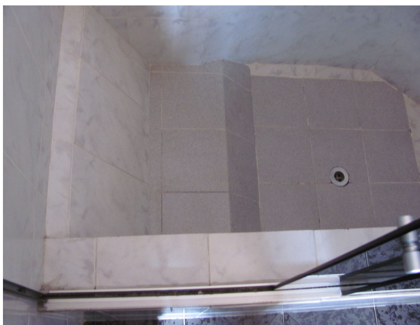
FOTO 116: Residência Raquel - vista interna da banheira do banheiro suíte - segundo pavimento.
