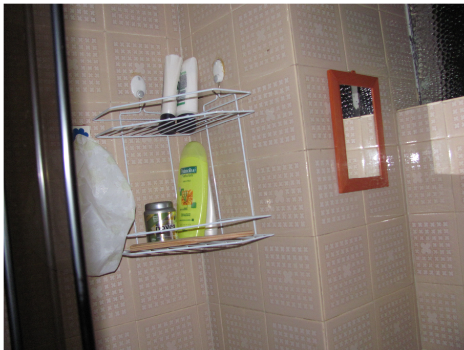
FOTO 23: Residência Fernando - detalhe do interior do boxe.
