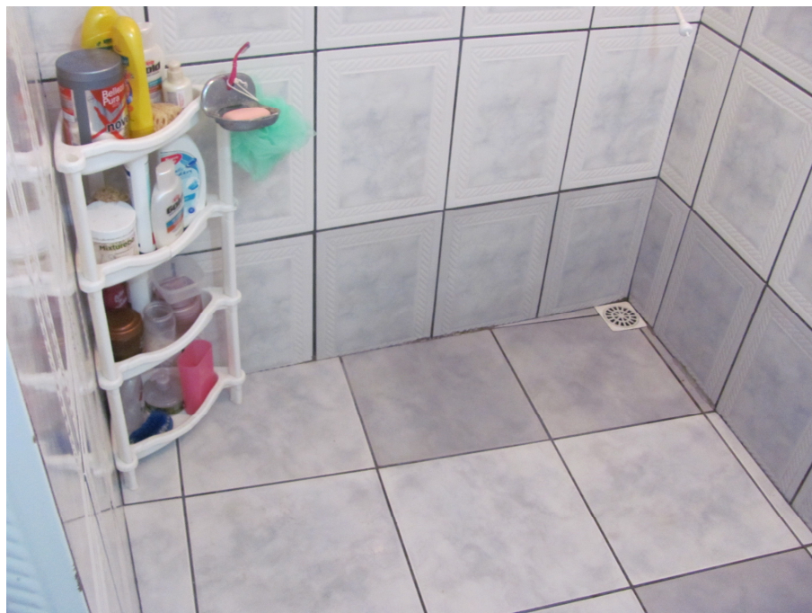
FOTO 33: Residência Mariana - detalhe da área do chuveiro.
