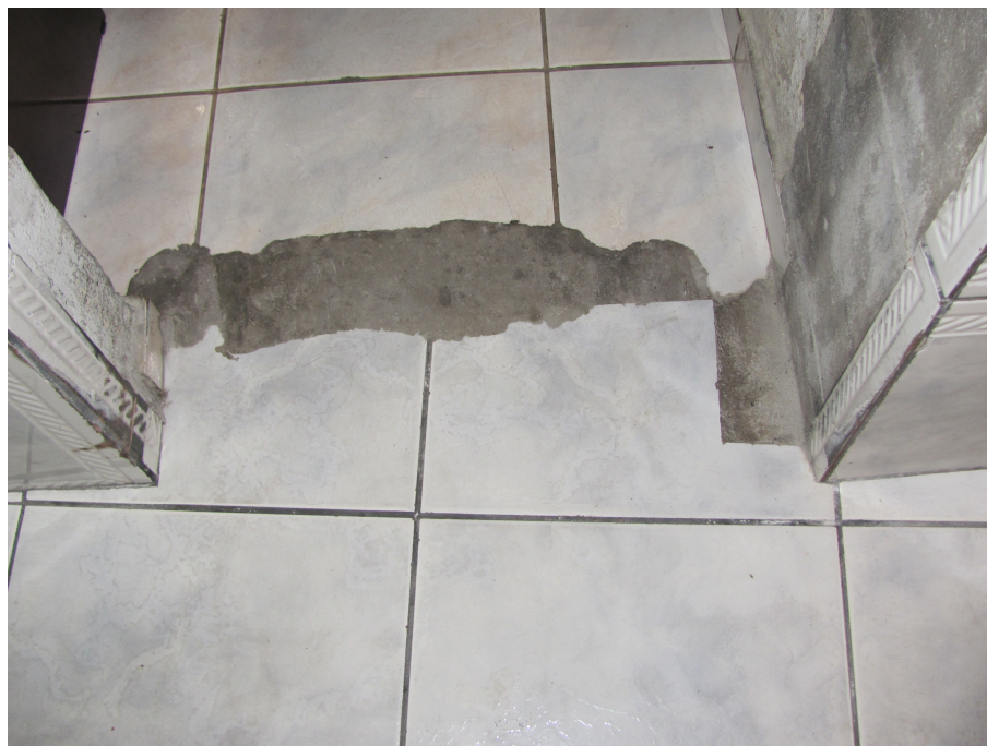
FOTO 35: Residência Mariana - detalhe do ressalto que foi retirado.
