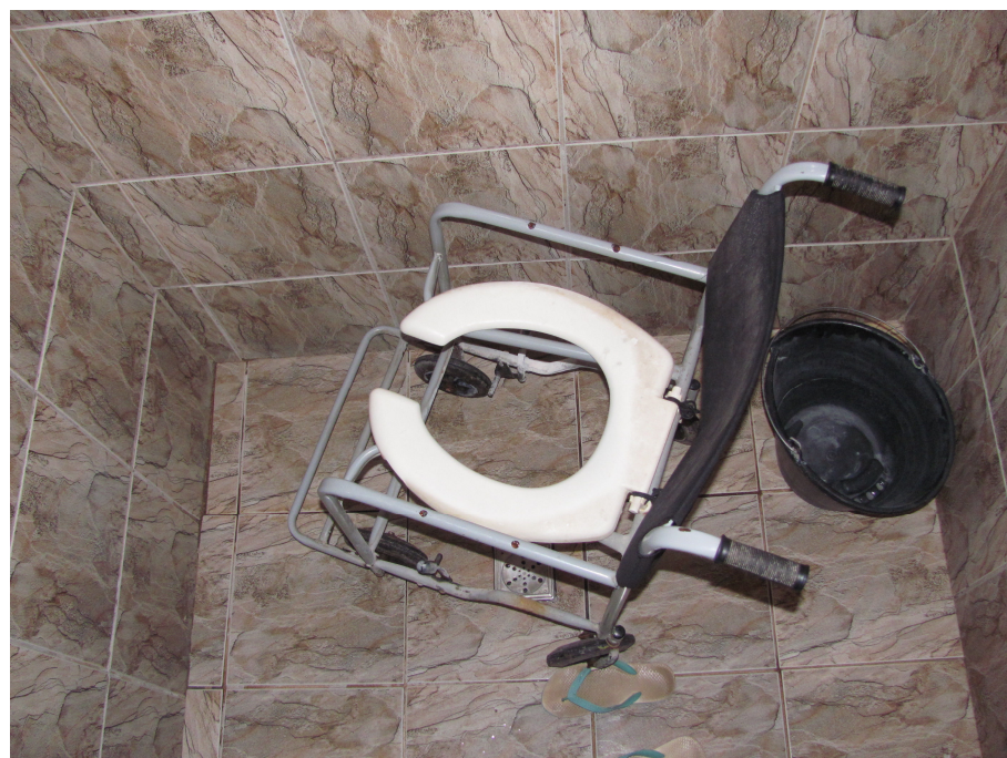
FOTO 123: Residência Pedro - vista superior do boxe do banheiro.
