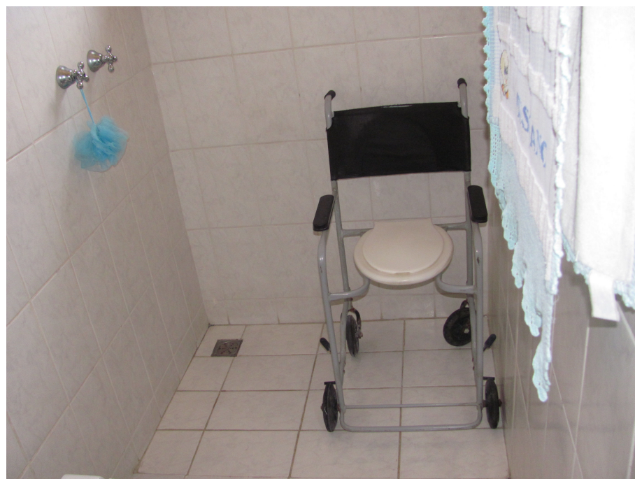
FOTO 42: Residência Rafael - detalhe do box do chuveiro sem divisórias no banheiro suíte.
