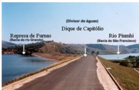
Foto 01: Dique de Capitólio – Fonte (PROJETO TRANSPIUMHI, 2011)
