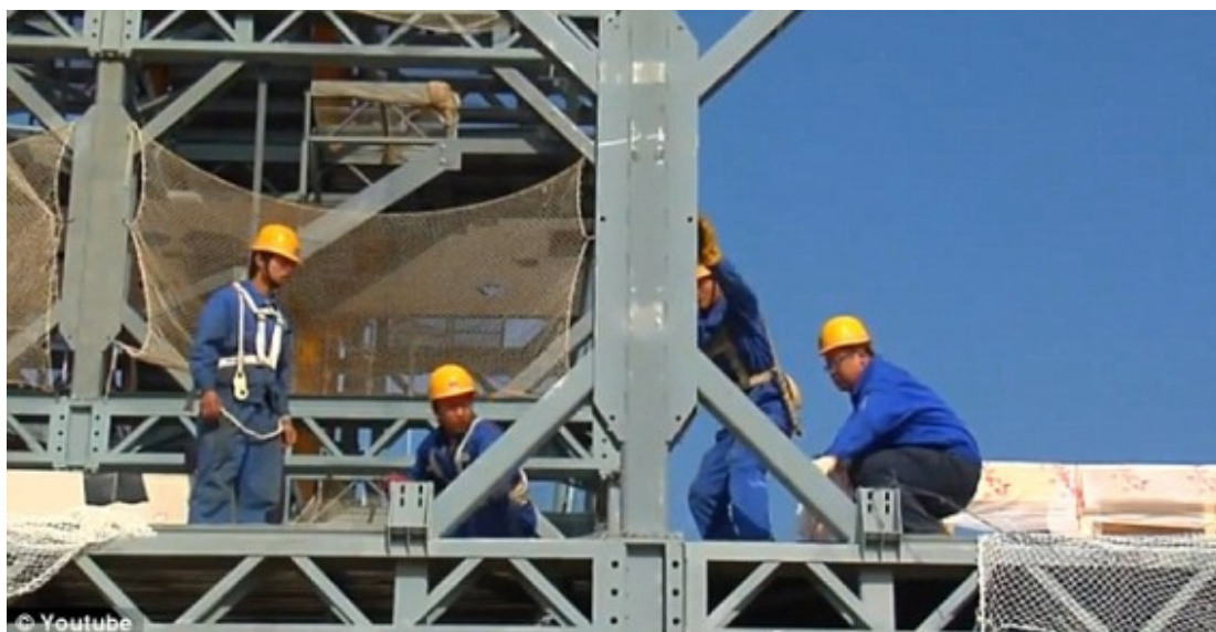
Figura 3.1.2.2: Montagem de pavimento pronto. http://www.engenhariaeconstrucao.com - 16.02.13
