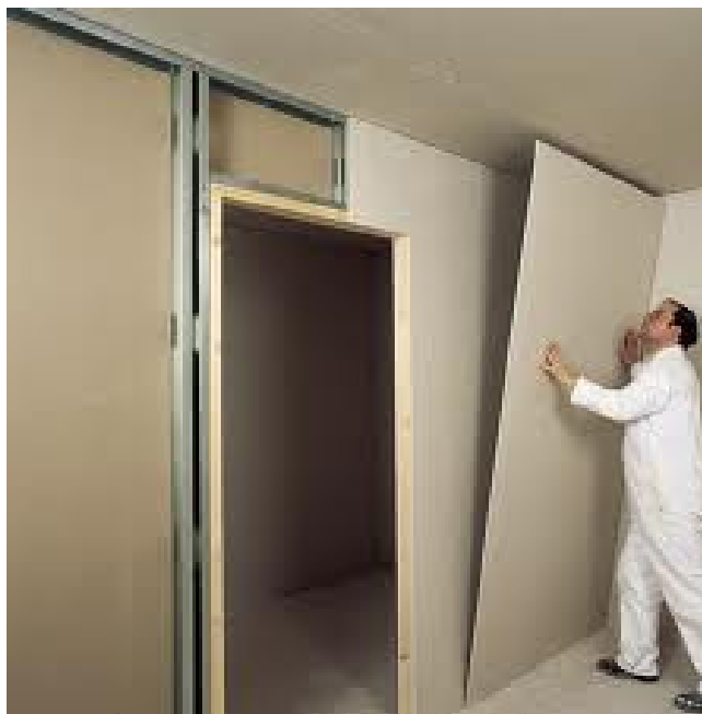
Figura 3.1.1.1 – Instalação de parede de gesso acartonado -
