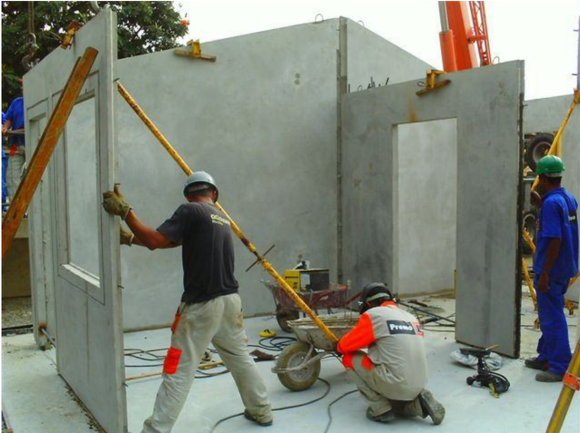
Figura 3.1.3.1 - Montagem de casa com paredes de concreto pré-fabricadas
