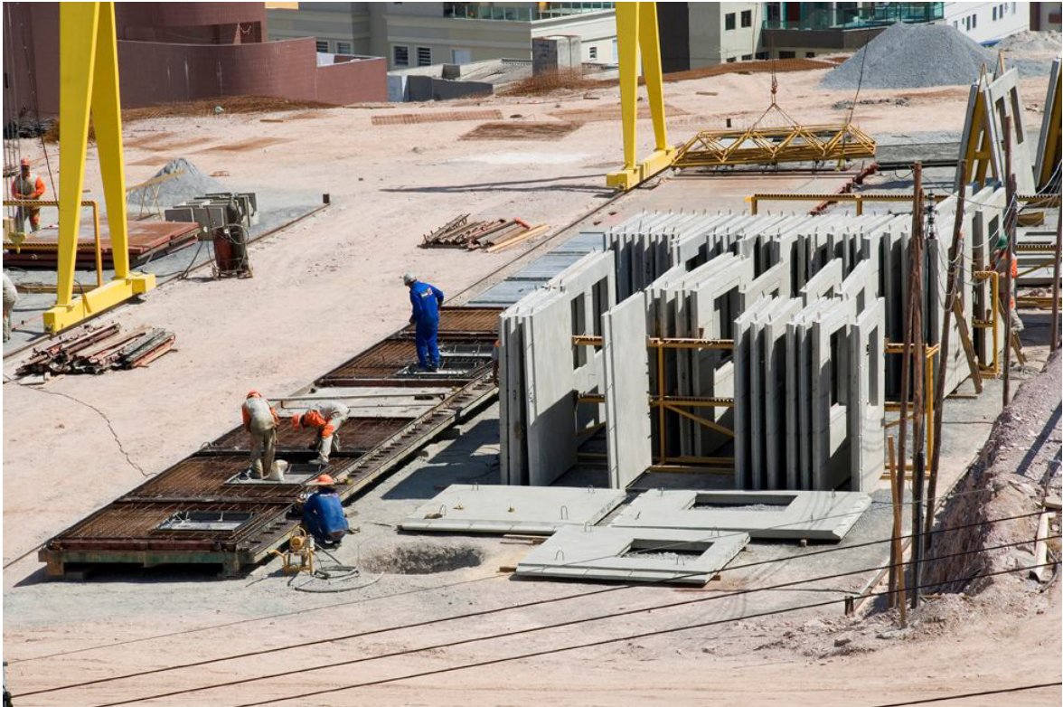
Figura 3.1.3.3 - Pré fabricação de painéis de parede de prédio residencial
