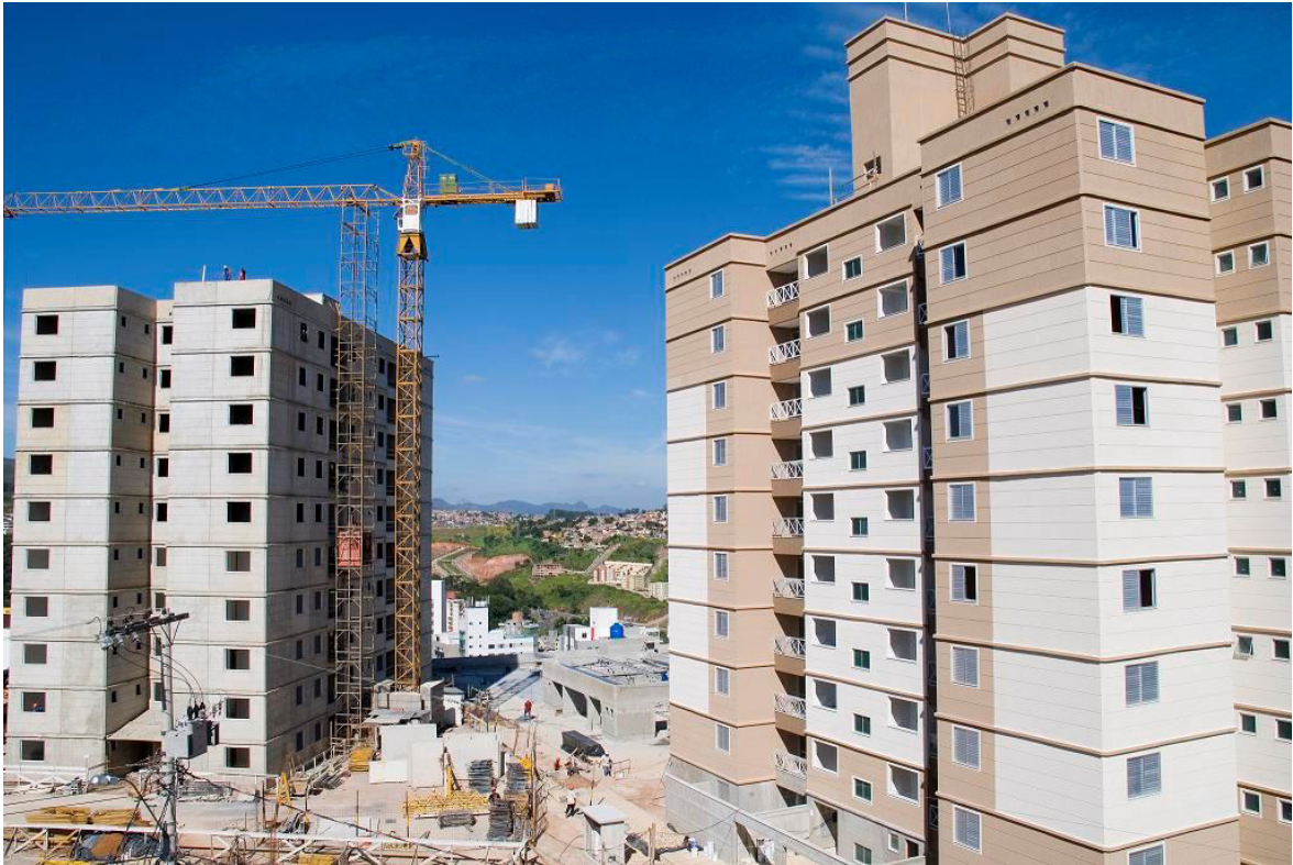
Figura 3.1.3.5 - Vista geral do edifício Piemonte
