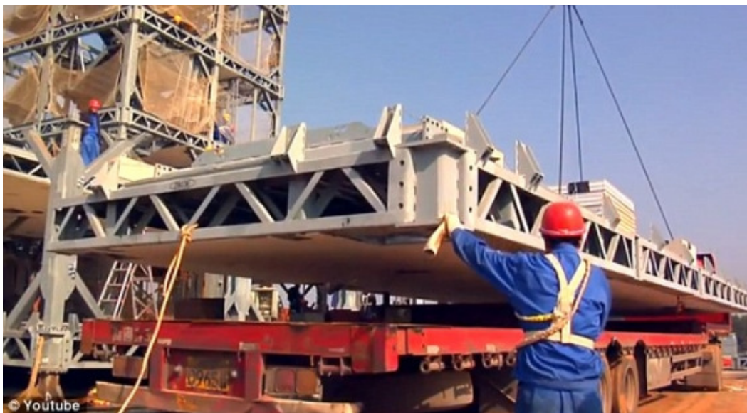
Figura 3.1.2.1: Transporte e içamento de pavimento pronto. http://www.engenhariaeconstrucao.com - 16.02.13
