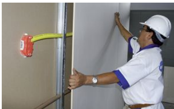
Figura 3.1.1.2 – Instalação de parede de drywall
