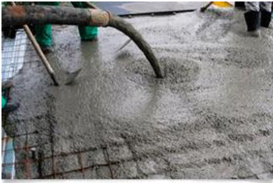
Figura 5.6 – Lançamento de concreto Fonte: http://www.acharimoveis.com/blog_imobiliario/?tag=tipos-de-concreto
