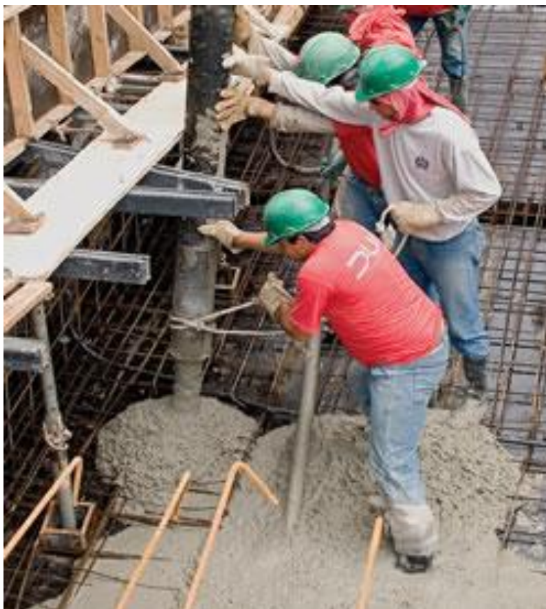
Figura 5.3 - Concretagem Fonte: www.arcoweb.com.br/
