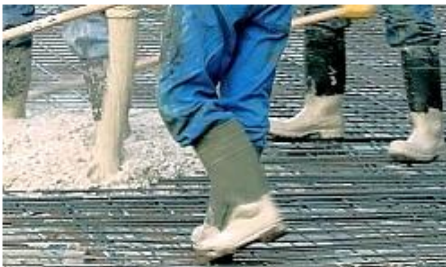
Figura 2.1 - Execução de concretagem na obra. Fonte: http://www.portaldoconcreto.com.br
