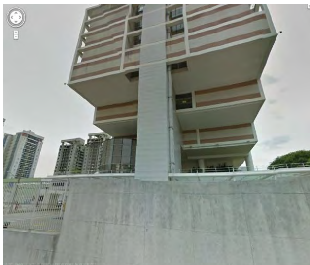
Figura 14 - Fachada Oeste – Rua Manoel Atouquia. (Fonte: http://maps.google.com.br/maps?hl=pt-BR&tab=w1 )
