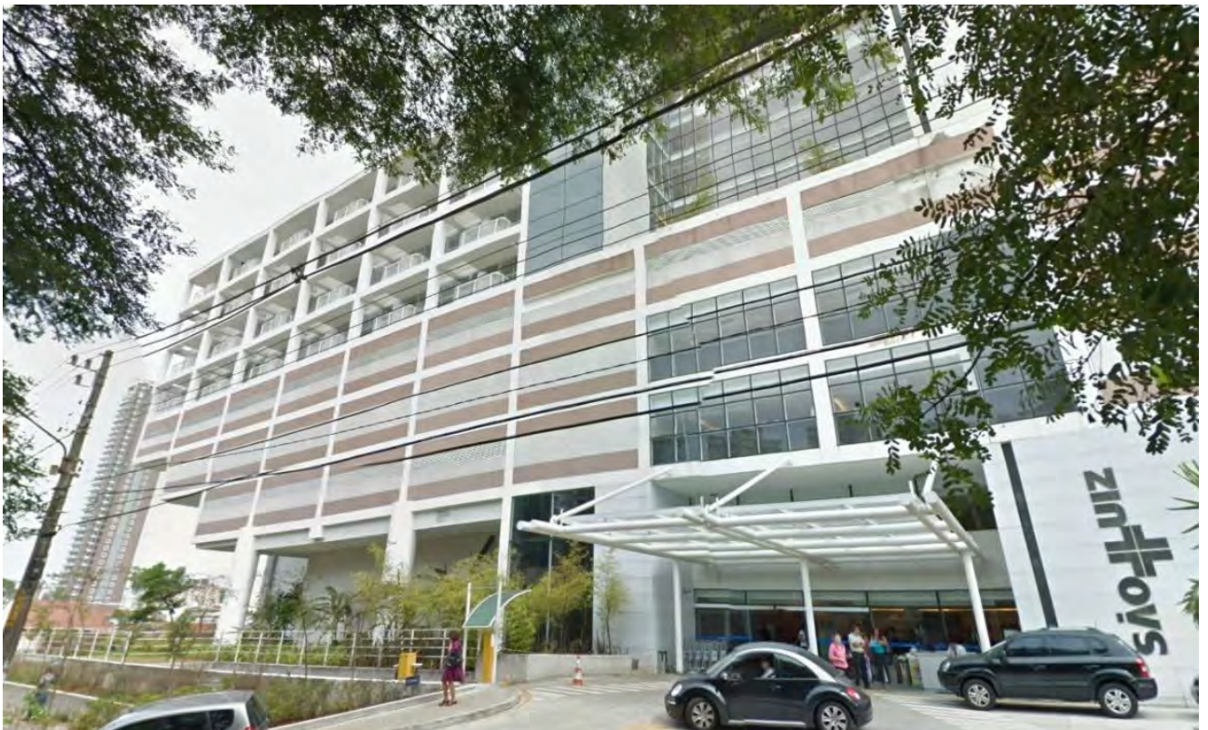
Figura 13 - Fachada Sul – Rua Corta Vento. (Fonte: http://maps.google.com.br/maps?hl=pt-BR&tab=w/ )
