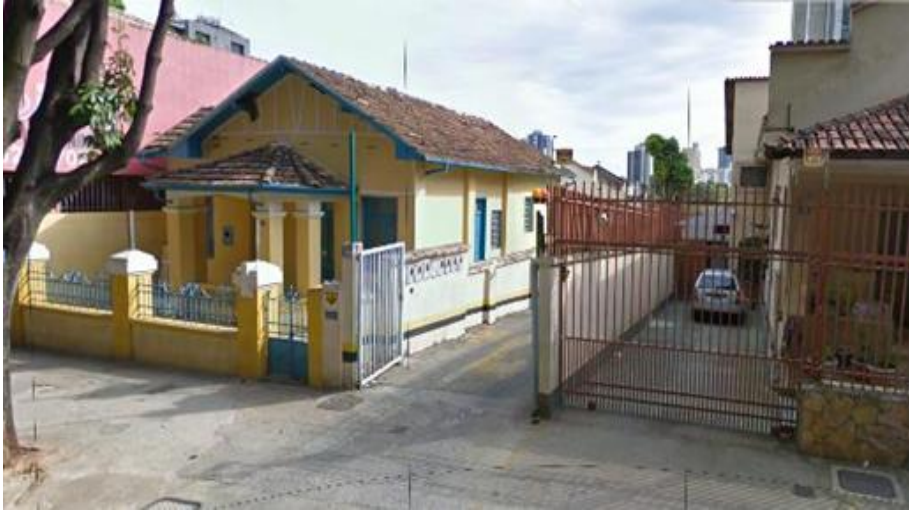
Figura 3 - Vista frontal da edificação Fonte: Google Earth Street View, 2011
