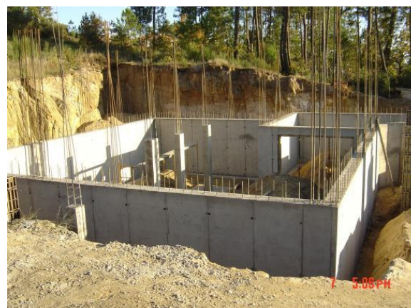
Figura 27 Paredes de concreto
