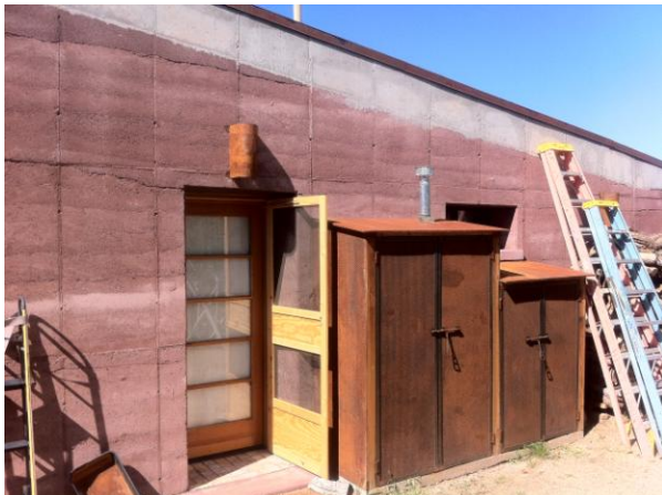
Figura 37 Viga sobre taipa de pilão
