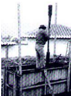
Figura 2 Técnicas mais comuns de construções com terra crua: (A) taipa de pilão; (B) tijolos de adobe; (C) pau-a-pique.
