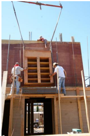
Figura 34 Fôrma para as aberturas
