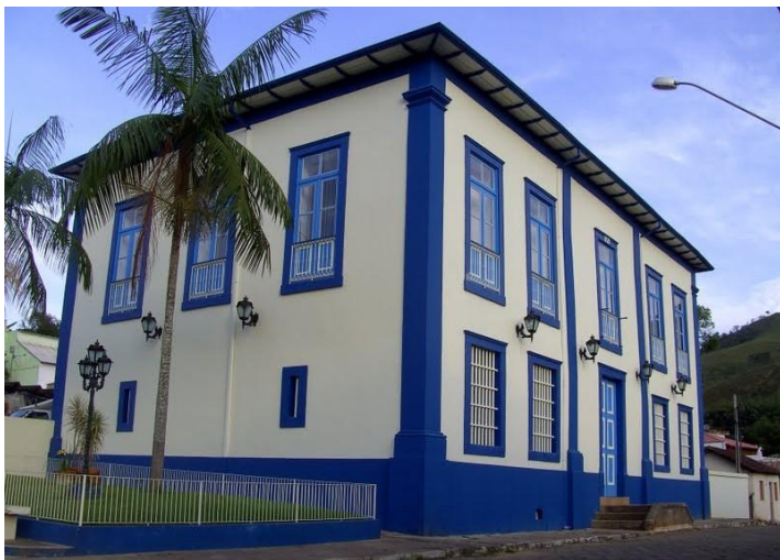
Figura 18 Fechamento com tijolos
