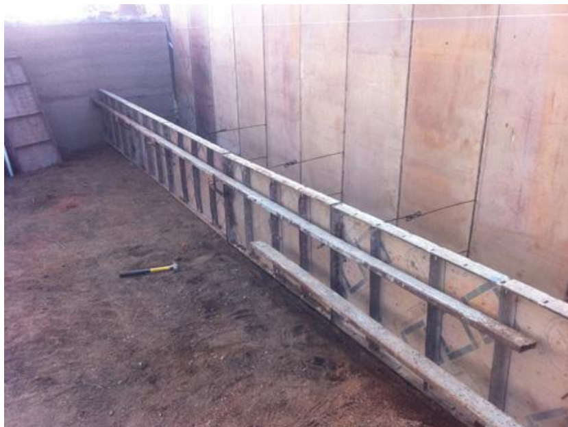
Figura 28 Painéis de taipa de pilão pneumática
