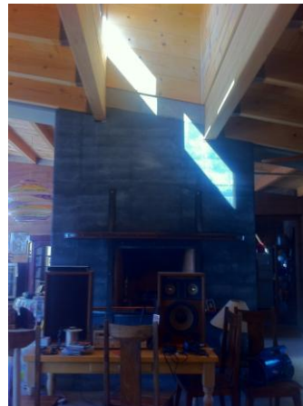
Figura 38 Cobertura apoiada sobre parede
