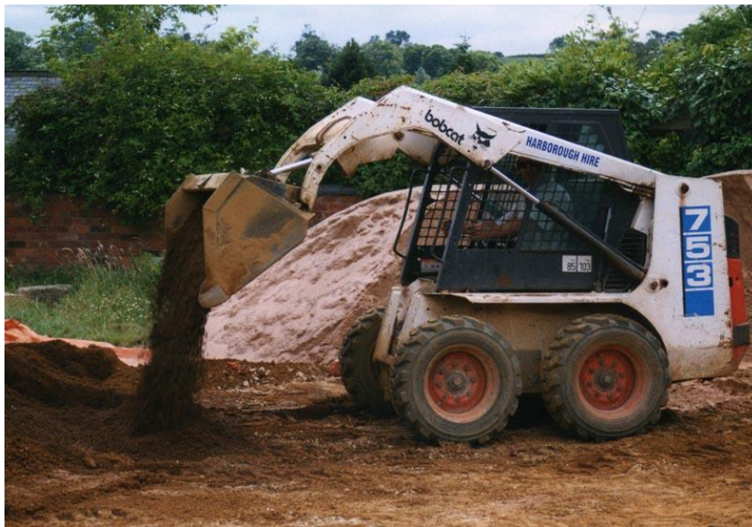
Figura 23 Mistura de terra estabilizada
