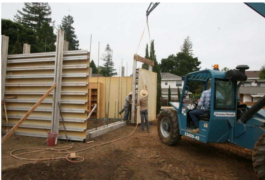
Figura 25 Montagem das fôrmas
