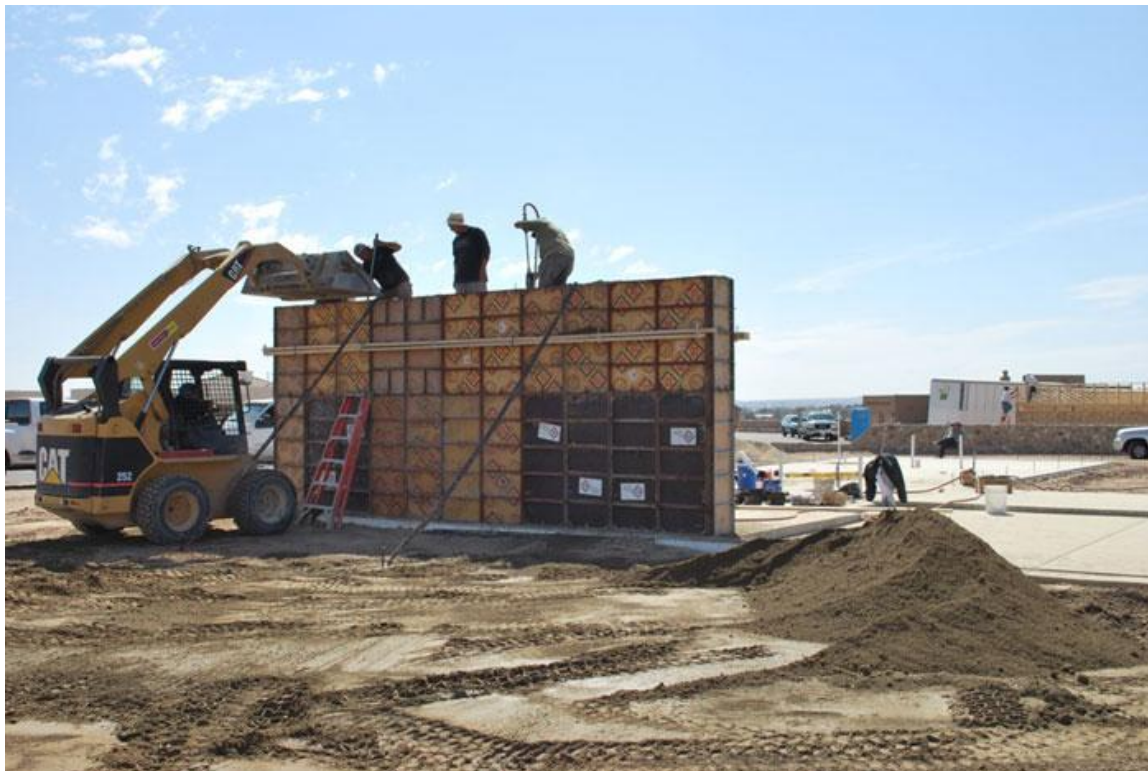
Figura 31 Preenchimento das fôrmas
