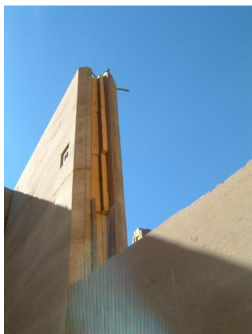
Figura 35 Instalação de esquadrias
