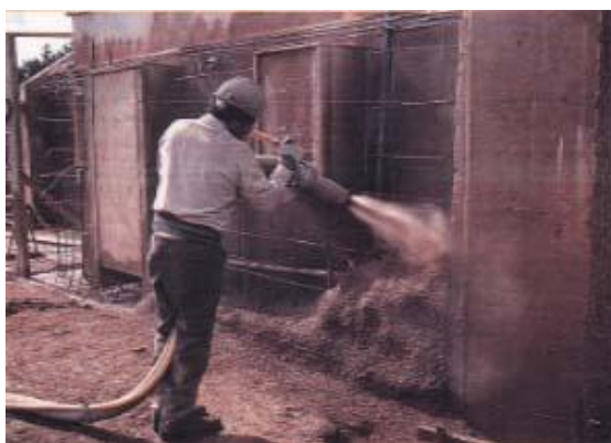
Figura 3 Jateamento da mistura de terra
