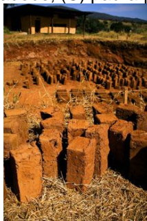
Figura 2 Técnicas mais comuns de construções com terra crua: (A) taipa de pilão; (B) tijolos de adobe; (C) pau-a-pique.
