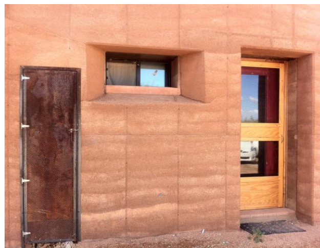
Figura 36 Chanfrado da janela
