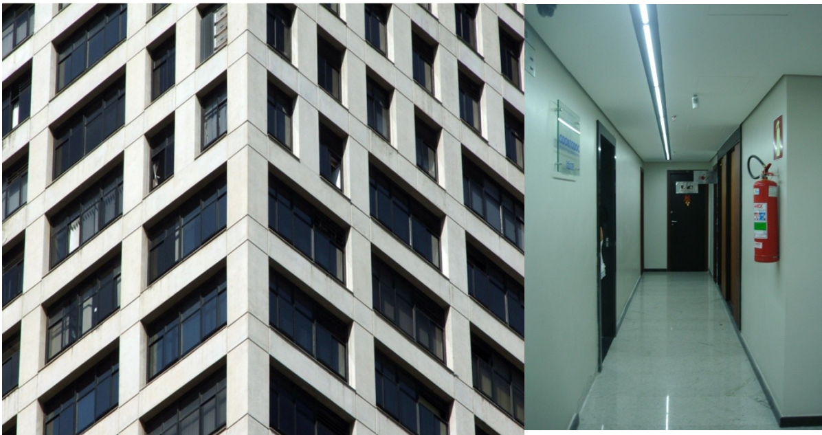
Fig. 04 – Foto detalhe fachada, 2011
