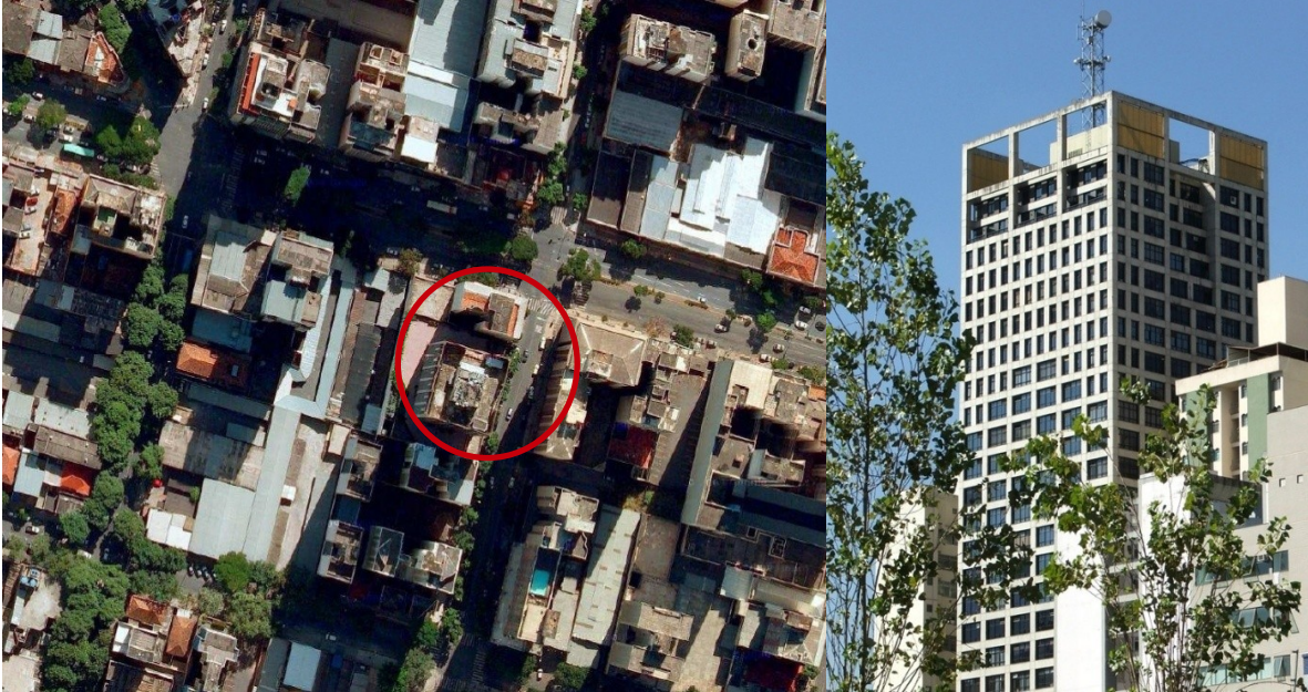
Fig. 02 – Vista aérea (Google Earth, 2011)
