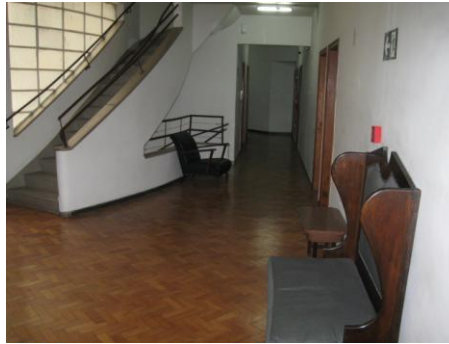
FOTO 35: ÁREA COMUM – CIRCULAÇÃO 6º ANDAR – PISO: TACO MADEIRA SINTECADO; RODAPÉ: ARDÓSIA (COR: VERDE ESCURO); PAREDES: EMASSADAS E PINTADAS (COR: BRANCO); ESCADA: PISO: GRANILITE (COR: BEGE); RODAPÉ: GRANILITE (COR: BEGE); GUARDA CORPO: PARTE EM ALVENARIA EMASSADA E PINTADA (COR: BRANCO) COM ACABAMENTO NA PARTE SUPERIOR EM GRANILITE (COR: BEGE) PARTE METÁLICO PINTADO (COR: MARROM). PORTAS: PORTAS, MARCOS E ALIZARES EM MADEIRA ENVERNIZADA, MAÇANETA TIPO BOLA CROMADA. TETO: EMASSADO E PINTADO (COR: BRANCO). PELA AUTORA – 09/2011.
