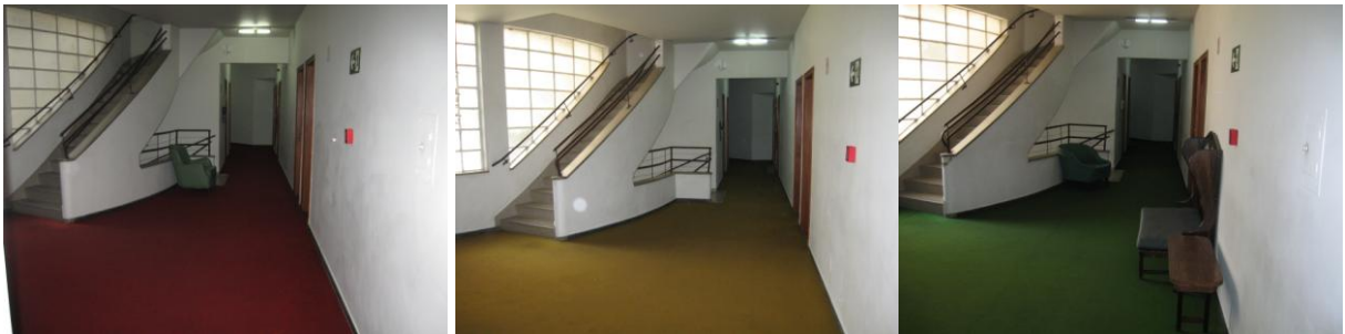
FOTO 42, 43 E 44: ÁREA COMUM – CIRCULAÇÃO 7º AO 10º, 12º, 13º E 15º ANDARES – PISO: CARPETE (COR: VERMELHO / MARRON / VERDE); RODAPÉ: ARDÓSIA (COR: VERDE ESCURO); PAREDES: EMASSADAS E PINTADAS (COR: BRANCO); ESCADA: PISO: GRANILITE (COR: BEGE); RODAPÉ: GRANILITE (COR: BEGE); GUARDA CORPO: PARTE EM ALVENARIA EMASSADA E PINTADA (COR: BRANCO) COM ACABAMENTO NA PARTE SUPERIOR EM GRANILITE (COR: BEGE) PARTE METÁLICO PINTADO (COR: MARROM). PORTAS: PORTAS, MARCOS E ALIZARES EM MADEIRA ENVERNIZADA, MAÇANETA TIPO BOLA CROMADA. TETO: EMASSADO E PINTADO (COR: BRANCO). PELA AUTORA – 09/2011.
