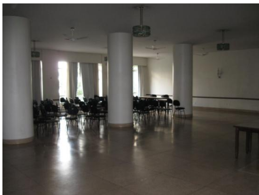
FOTO 29: SALÃO EVENTOS 01 – SALÃO TIRADENTES– PISO: GRANILITE (COR: BEGE); RODAPÉ: GRANILITE (COR: BEGE); PAREDE: EMASSADA E PINTADA (COR: BRANCO) ESQUADRIAS: JANELAS METÁLICAS PINTADAS (COR: BRANCO). PELA AUTORA – 09/2011.
