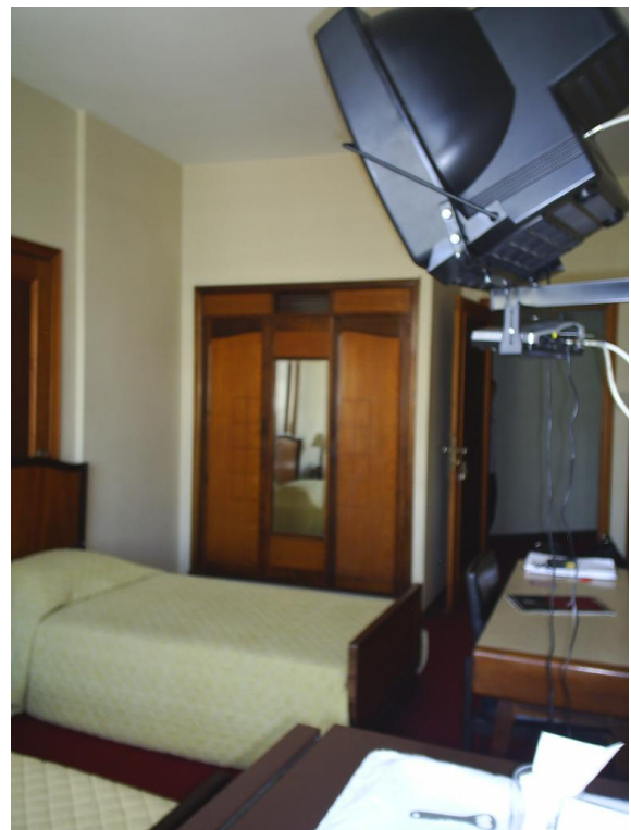
FOTO 36 E 37: APARTAMENTO 6º ANDAR (612) – PISO: CARPETE (COR: VERMELHO); RODAPÉ: ARDÓSIA (COR: VERDE ESCURO); PAREDES: EMASSADAS E PINTADAS (COR: PALHA); TETO: EMASSADO E PINTADO (COR: BRANCO). PORTAS: PORTAS, MARCOS E ALIZARES EM MADEIRA ENVERNIZADA, MAÇANETA TIPO BOLA CROMADA. PELA AUTORA – 09/2011.
