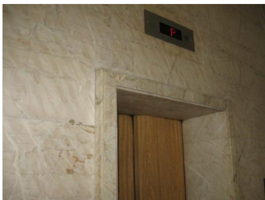
FOTO 27 E 28: HALL 3º PAVIMENTO – DETALHE CX. ELEVADORES– PISO: GRANILITE (COR: BEGE); REVESTIMENTO DA CAIXA DE ELEVADORES EM MÁRMORE (COR: BEGE COM VEIOS BRANCOS E MARRONS); PORTAS ELEVADORES – REVESTIMENTO MADEIRA. PELA AUTORA – 09/2011.
