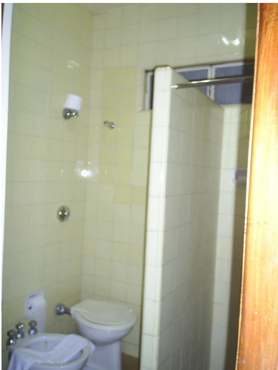
FOTO 40 E 41: SANITÁRIO APARTAMENTO (VARIAÇÕES NO ACABAMENTO) – PISO: CERÂMICA 30X30 CM (COR: MARRON CLARO); PAREDES: CERÂMICA 15X15 CM (COR: AMARELO CLARO E AMARELO ESCURO – RECORTES DEVIDO REFORMAS); TETO: EMASSADO E PINTADO (COR: BRANCO). PORTAS: PORTAS, MARCOS E ALIZARES EM MADEIRA ENVERNIZADA, MAÇANETA TIPO BOLA CROMADA. PELA AUTORA – 09/2011.
