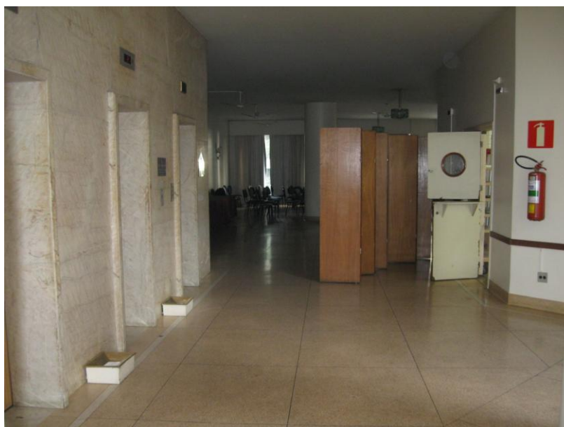
FOTO 26: HALL 3º PAVIMENTO – ACESSO SALÃO TIRADENTES – PISO: GRANILITE (COR: BEGE); REVESTIMENTO DA CAIXA DE ELEVADORES EM MÁRMORE (COR: BEGE COM VEIOS BRANCOS E MARRONS) E DEMAIS PAREDES EMASSADAS E PINTADAS (COR: BRANCO); RODAPÉ: GRANILITE (COR: BEGE). PELA AUTORA – 09/2011.
