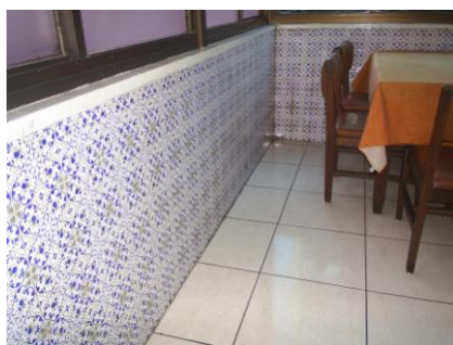
FOTO 20 E 21: RESTAURANTE – DETALHE: PEITORIL E PAREDES EM CERÂMICA PORTUGUESA. ESTE ACABAMENTO FOI INTRODUZIDO EM UMA DAS REFORMAS DO HOTEL ONDE A VARANDA FOI INCORPORADA AO RESTAURANTE. FOTOS PELA AUTORA – 09/2011.
