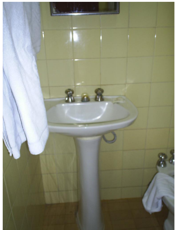
FOTO 40 E 41: SANITÁRIO APARTAMENTO (VARIAÇÕES NO ACABAMENTO) – PISO: CERÂMICA 30X30 CM (COR: MARRON CLARO); PAREDES: CERÂMICA 15X15 CM (COR: AMARELO CLARO E AMARELO ESCURO – RECORTES DEVIDO REFORMAS); TETO: EMASSADO E PINTADO (COR: BRANCO). PORTAS: PORTAS, MARCOS E ALIZARES EM MADEIRA ENVERNIZADA, MAÇANETA TIPO BOLA CROMADA. PELA AUTORA – 09/2011.
