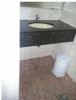
FOTO 22, 23 E 24: SANITÁRIO MASCULINO E FEMININO (RESTAURANTE) – PISO: CERÂMICA; PAREDE: CERÂMICA; BANCADA: GRANITO COM CUBA LOUÇA, TORNEIRA TEMPORIZADA CROMADA, VASO E MICTÓRIO EM LOUÇA. ACABAMENTO POSTERIOR A DATA DA CONSTRUÇÃO, INTRODUZIDO EM UMA DAS REFORMAS. FOTOS PELA AUTORA – 09/2011.
