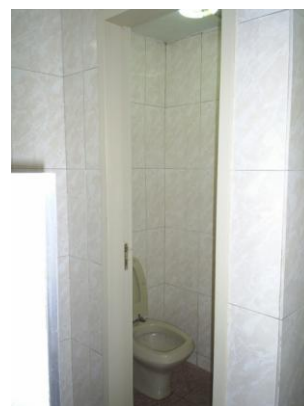
FOTO 22, 23 E 24: SANITÁRIO MASCULINO E FEMININO (RESTAURANTE) – PISO: CERÂMICA; PAREDE: CERÂMICA; BANCADA: GRANITO COM CUBA LOUÇA, TORNEIRA TEMPORIZADA CROMADA, VASO E MICTÓRIO EM LOUÇA. ACABAMENTO POSTERIOR A DATA DA CONSTRUÇÃO, INTRODUZIDO EM UMA DAS REFORMAS. FOTOS PELA AUTORA – 09/2011.
