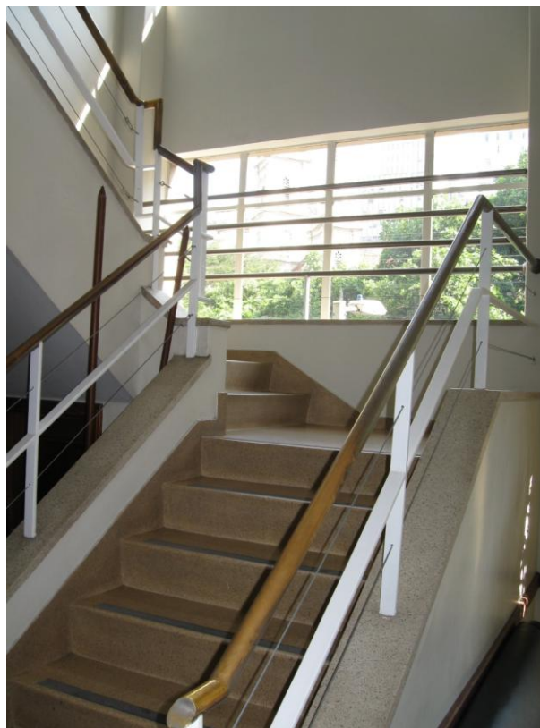
FOTO 25: HALL 3º PAVIMENTO - ESCADA ACESSO 3º PARA 4º PAVIMENTO – PISO: GRANILITE (COR: BEGE); PAREDE: EMASSADA E PINTADA (COR: BRANCO E PALHA); PEITORIL: ACABAMENTO SUPERIOR GRANILITE (COR: BEGE) E GUARDA CORPO METÁLICO (LATÃO POLIDO E PINTURA COR BRANCO). PELA AUTORA – 09/2011.
