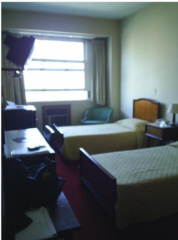
FOTO 36 E 37: APARTAMENTO 6º ANDAR (612) – PISO: CARPETE (COR: VERMELHO); RODAPÉ: ARDÓSIA (COR: VERDE ESCURO); PAREDES: EMASSADAS E PINTADAS (COR: PALHA); TETO: EMASSADO E PINTADO (COR: BRANCO). PORTAS: PORTAS, MARCOS E ALIZARES EM MADEIRA ENVERNIZADA, MAÇANETA TIPO BOLA CROMADA. PELA AUTORA – 09/2011.
