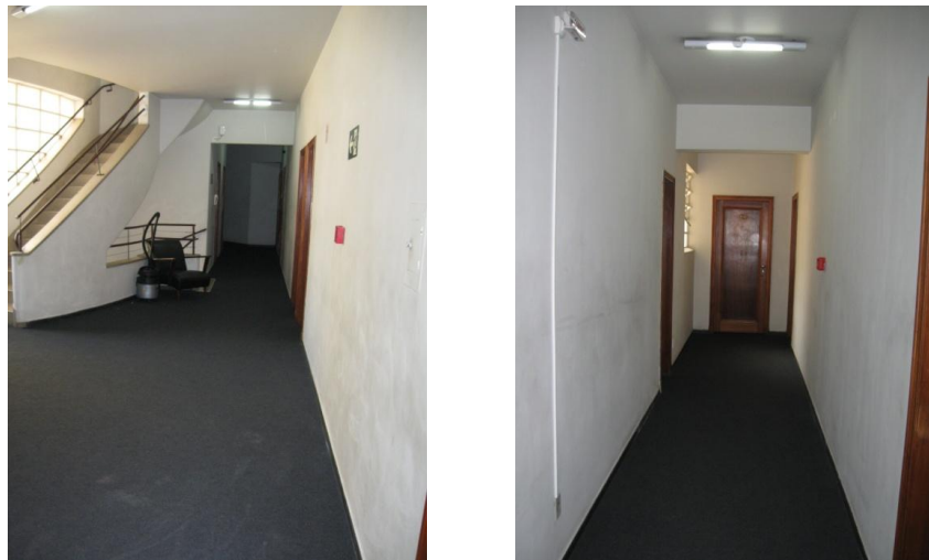
FOTO 45 E 46: ÁREA COMUM – CIRCULAÇÃO 11º ANDAR – PISO: CARPETE (COR: CINZA); RODAPÉ: ARDÓSIA (COR: VERDE ESCURO); PAREDES: EMASSADAS E PINTADAS (COR: BRANCO); ESCADA: PISO: GRANILITE (COR: BEGE); RODAPÉ: GRANILITE (COR: BEGE); GUARDA CORPO: PARTE EM ALVENARIA EMASSADA E PINTADA (COR: BRANCA) COM ACABAMENTO NA PARTE SUPERIOR EM GRANILITE (COR: BEGE) PARTE METÁLICO PINTADO (COR: MARROM). PORTAS: PORTAS, MARCOS E ALIZARES EM MADEIRA ENVERNIZADA, MAÇANETA TIPO BOLA CROMADA. TETO: EMASSADO E PINTADO (COR: BRANCO). PELA AUTORA – 09/2011.
