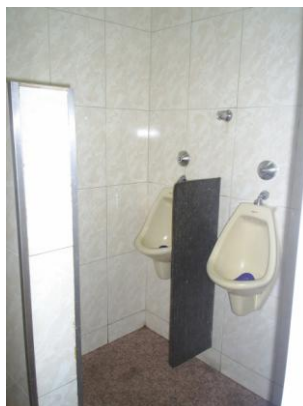
FOTO 22, 23 E 24: SANITÁRIO MASCULINO E FEMININO (RESTAURANTE) – PISO: CERÂMICA; PAREDE: CERÂMICA; BANCADA: GRANITO COM CUBA LOUÇA, TORNEIRA TEMPORIZADA CROMADA, VASO E MICTÓRIO EM LOUÇA. ACABAMENTO POSTERIOR A DATA DA CONSTRUÇÃO, INTRODUZIDO EM UMA DAS REFORMAS. FOTOS PELA AUTORA – 09/2011.
