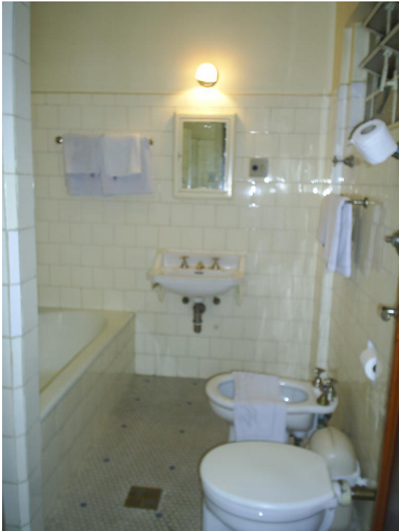
FOTO 38 E 39: SANITÁRIO APARTAMENTO 6º ANDAR – PISO: CERÂMICA SEXTAVADA (COR: BRANCO E DETALHES AZUL); PAREDES: BARRADO CERÂMICA 15X15 CM (COR: BRANCO) ACIMA BARRADO EMASSADO E PINTADO (COR: BRANCO); TETO: EMASSADO E PINTADO (COR: BRANCO). PORTAS: PORTAS, MARCOS E ALIZARES EM MADEIRA ENVERNIZADA, MAÇANETA TIPO BOLA CROMADA. PELA AUTORA – 09/2011.
