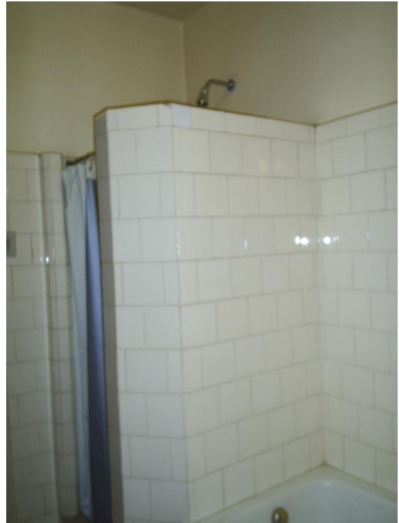
FOTO 38 E 39: SANITÁRIO APARTAMENTO 6º ANDAR – PISO: CERÂMICA SEXTAVADA (COR: BRANCO E DETALHES AZUL); PAREDES: BARRADO CERÂMICA 15X15 CM (COR: BRANCO) ACIMA BARRADO EMASSADO E PINTADO (COR: BRANCO); TETO: EMASSADO E PINTADO (COR: BRANCO). PORTAS: PORTAS, MARCOS E ALIZARES EM MADEIRA ENVERNIZADA, MAÇANETA TIPO BOLA CROMADA. PELA AUTORA – 09/2011.
