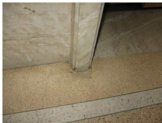
FOTO 27 E 28: HALL 3º PAVIMENTO – DETALHE CX. ELEVADORES– PISO: GRANILITE (COR: BEGE); REVESTIMENTO DA CAIXA DE ELEVADORES EM MÁRMORE (COR: BEGE COM VEIOS BRANCOS E MARRONS); PORTAS ELEVADORES – REVESTIMENTO MADEIRA. PELA AUTORA – 09/2011.
