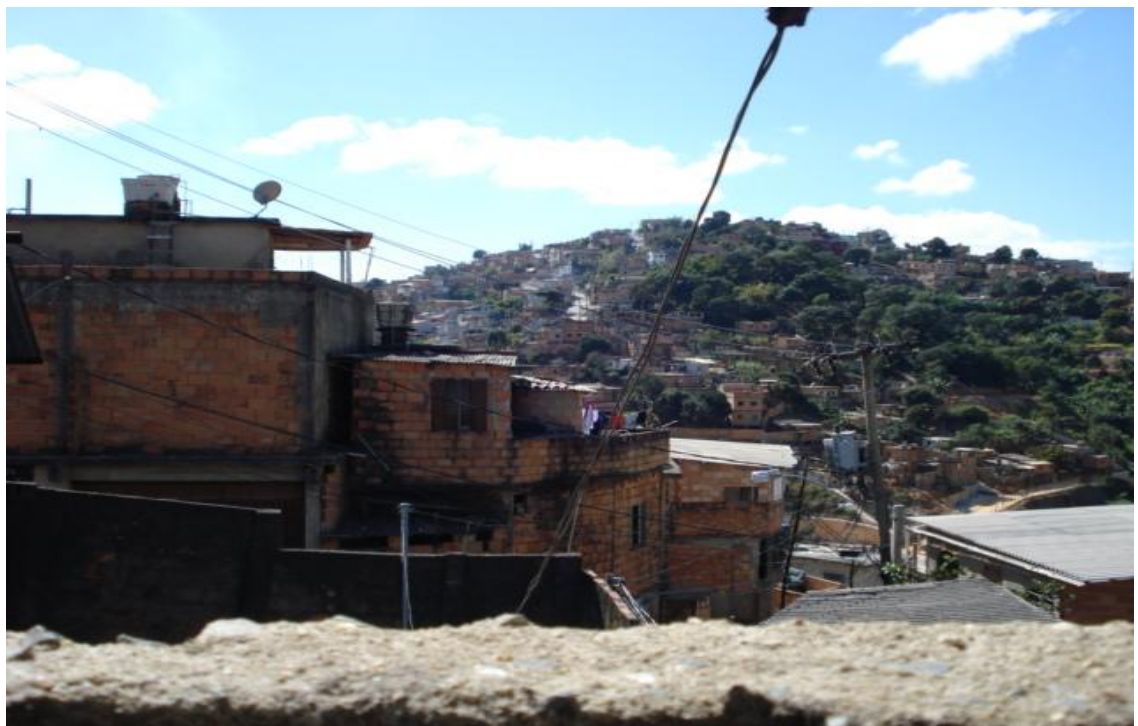
FIGURA 7 – Vista parcial da Vila do Cafezal
