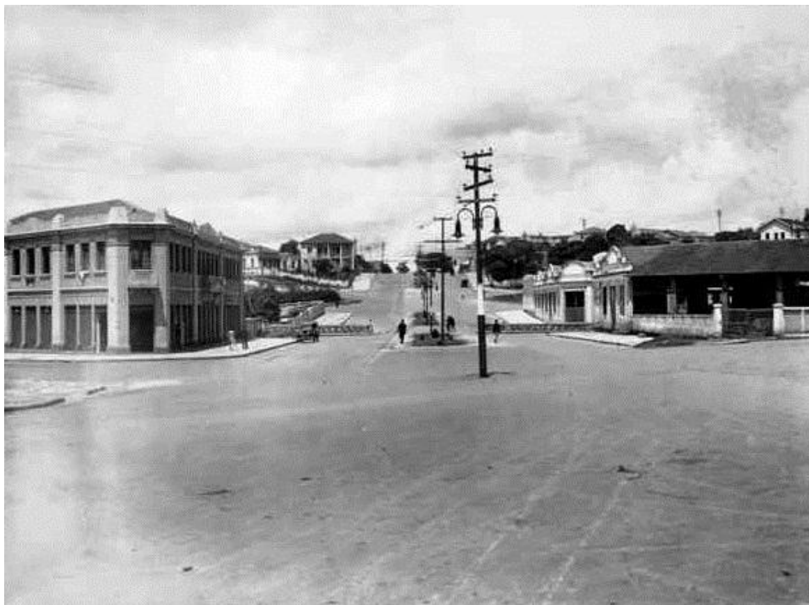
FIGURA 66 - Calçamento da Avenida Amazonas entre Praça Sete e Rua Goitacazes
