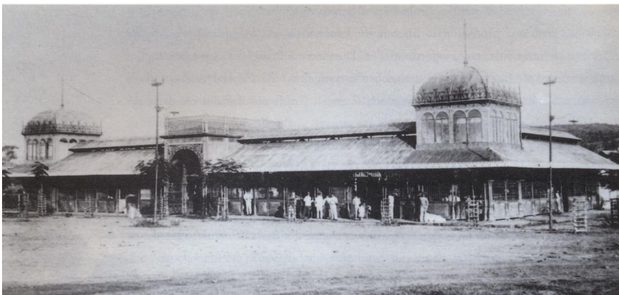
FIGURA 47 - Primeiro Mercado Municipal de Belo Horizonte (fachada) FONTE: MHAB
