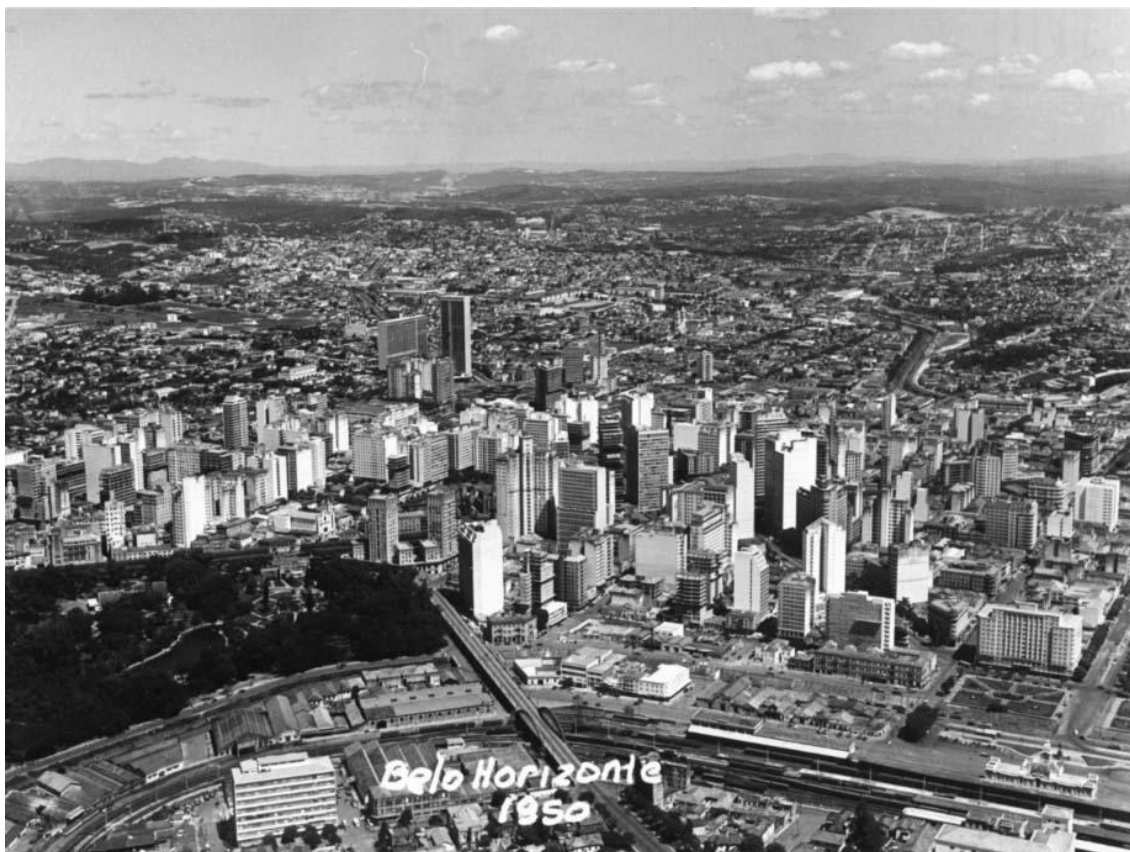
FIGURA 105 - Viaduto Santa Tereza
