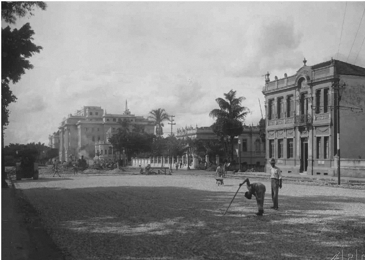
FIGURA 91 – Calçamento de um trecho da Praça da Liberdade Fonte: APM
