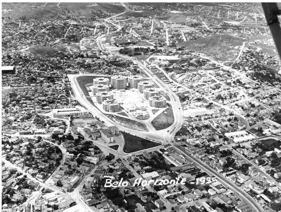
FIGURA 114- Vista da Cidade: Conjunto IAPI em 1955
