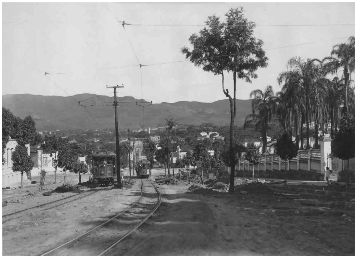
FIGURA 93 – Calçamento de trecho da Av. Cristóvão Colombo Fonte: APM
