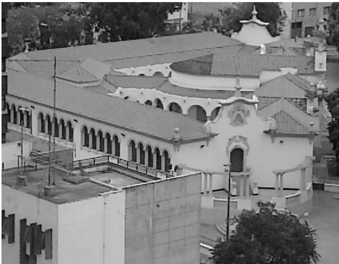
FIGURA 100 – Grupo Escolar Pedro II (vista lateral do alto)
