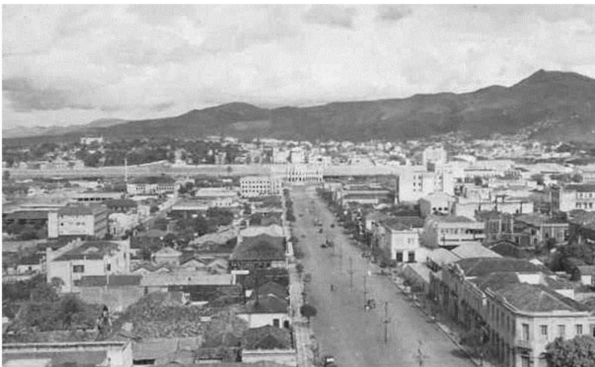
FIGURA 51 – Avenida Santos Dumont e a sede atual da estação da Estrada de Ferro Central do Brasil
