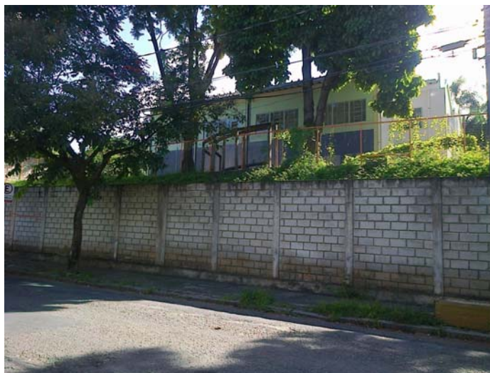
Figura 7 – Vista lateral do CERSAM Leste
