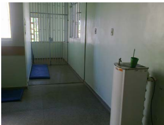
Figura 12 – Portão (com cadeado) do segundo andar que dá acesso à rampa para o primeiro andar
