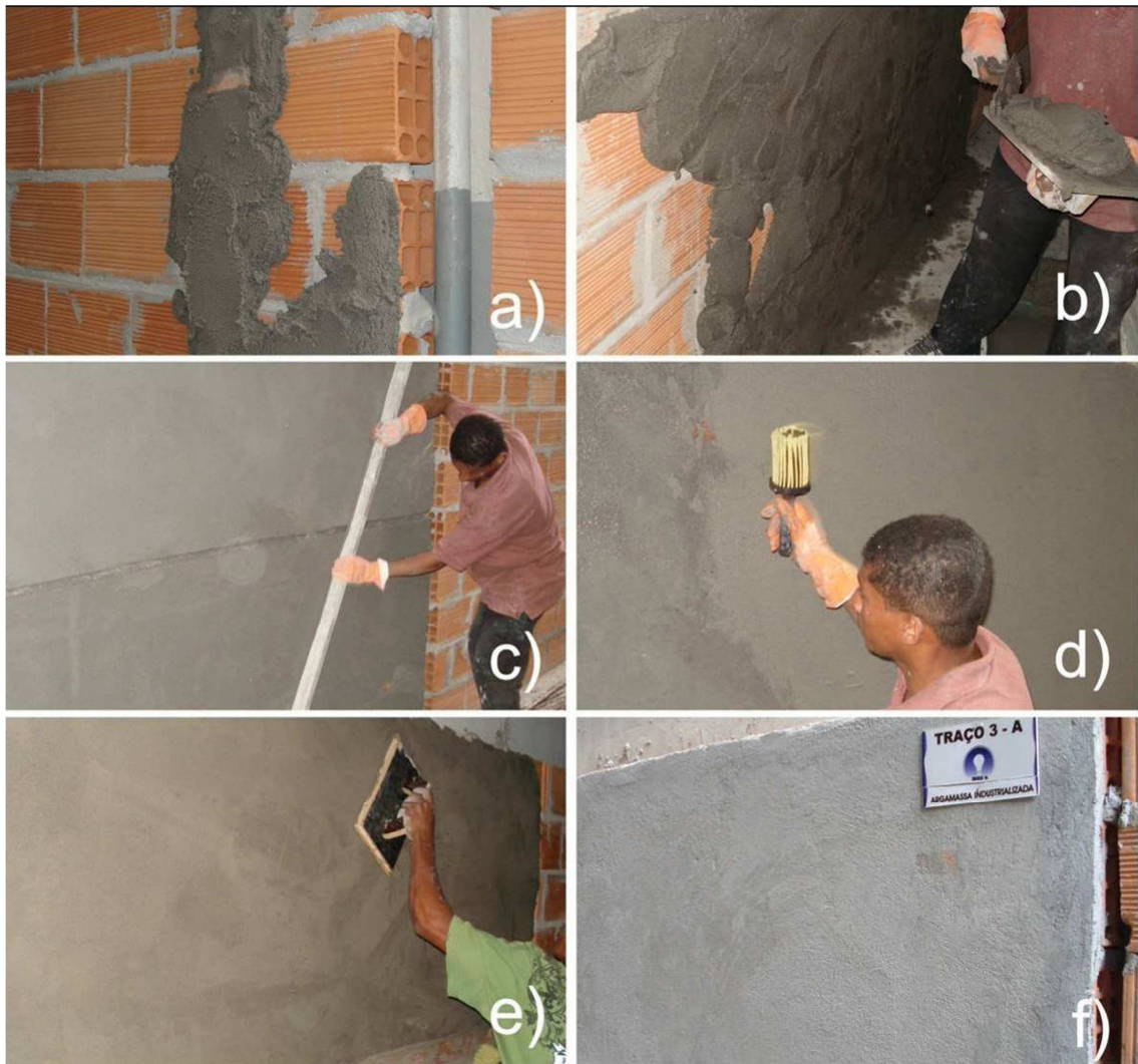
Figura 4.4 - Processo de execução da argamassa. a) taliscas; b) projeção da argamassa; c) sarrafeamento; d) aspersão de água; e) desempeno; f) identificação dos painéis.
