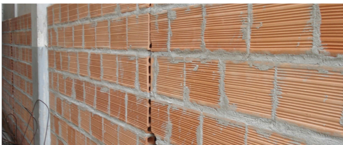
Figura 4.2 - Aspecto final da alvenaria utilizada como base para aplicação das argamassas.
