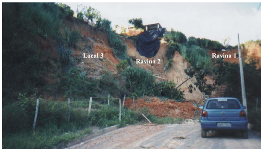
FIGURA 4.27- Vista geral das ravinas do Talude Engenho Nogueira em 2003 (Parizzi, 2004)
