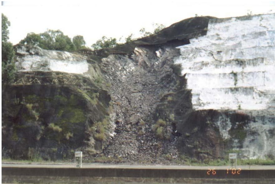
FIGURA 4.1- Vista do Talude Ponteio em 2002 (Parizzi, 2004)
