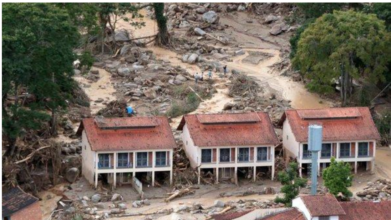
FIGURA 1.2- Danos associados às corridas de massa em Teresópolis, janeiro de 2011 ( http://veja.abril.com.br/multimedia/galeria-fotos/chuvas-no-rio-de-janeiro )
