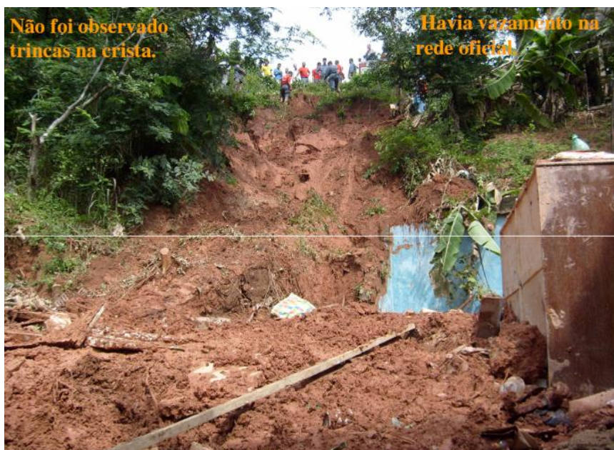
FIGURA 4.32- Vista da ruptura do Talude Juliana e muro de 2,8m que serviu de anteparo (Urbel, 2010)
