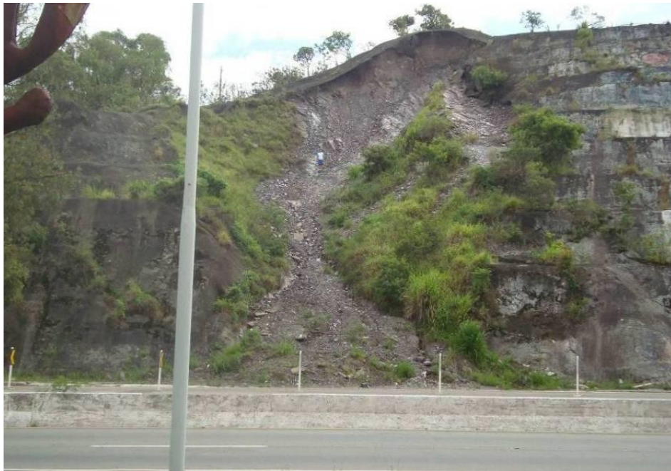
FIGURA 4.4 - Vista do Talude Ponteio em 2010
