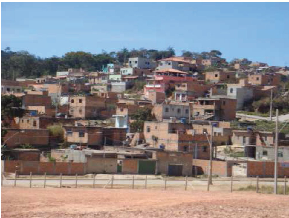
Figura 20 – Vista geral do loteamento Gávea II. Fonte: Processo Administrativo 1722/2002, SEMAD.
