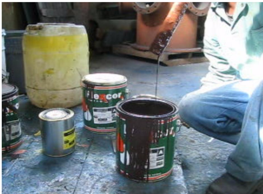
Figura 10. Preparo da diluição da tinta e verificação de sua viscosidade realizado pelo pintor.
