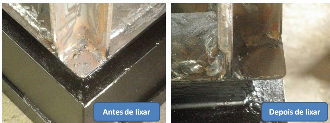
Figura 7. Peça antes e após lixamento realizado pelo pintor.
