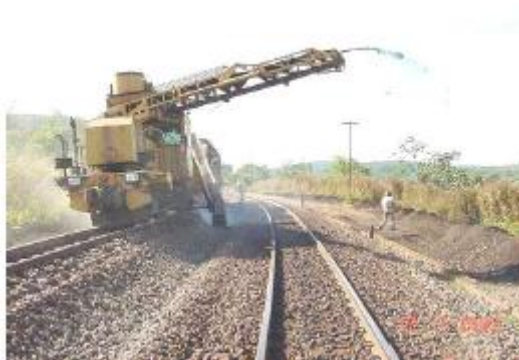
FIGURA 3.17 – Desguarnecimento mecanizado de lastro. (FONTE-ANTF, 2010)
