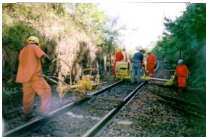
FIGURA 3.14 - Retirada mecanizada de fixação. (FONTE- ANTF, 2010)
