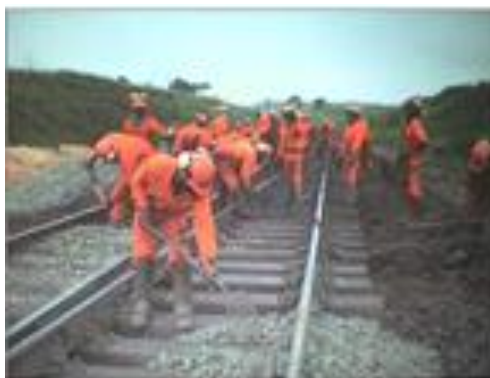
FIGURA 3.16 –Desguarnecimento manual de lastro em região de AMV. (FONTE-ANTF, 2010)
