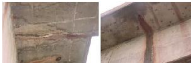
FIGURA 3.28 - Intervenção em obra de arte especial. (FONTE - ANTF, 2009).
