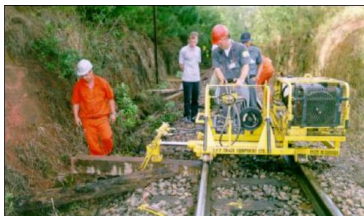
FIGURA 3.15 – Troca mecanizada de dormentes. (FONTE-ANTF, 2010)
