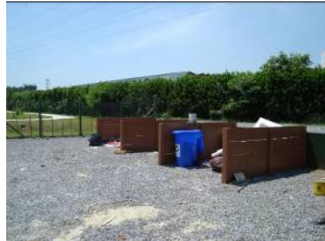
Figura 3.7: Baías de armazenamento de resíduos leves do Ecoponto em São José dos Campos-SP
