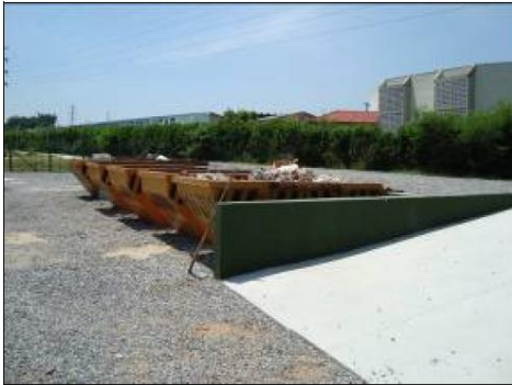
Figura 3.6: Ecoponto com caçambas para resíduos densos em São José dos Campos-SP
