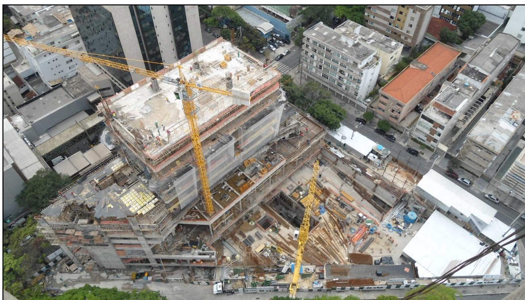
Figura 7.2 – Canteiro de Obras
