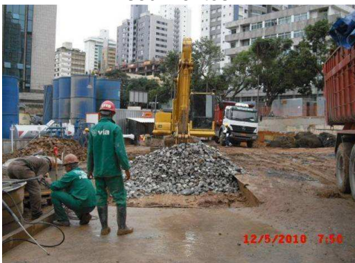
Substituição das pedras na bacia metálica, para retenção de sedimentos.
