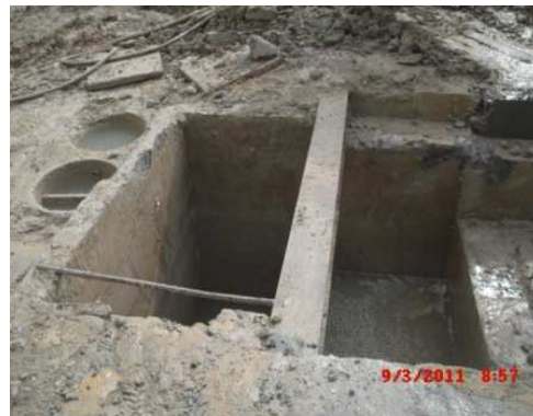
Limpeza das caixas de decantação
