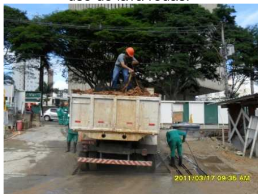
Detalhe do uso de 2 hidrolavadoras e colocação de lona na carroceria.
