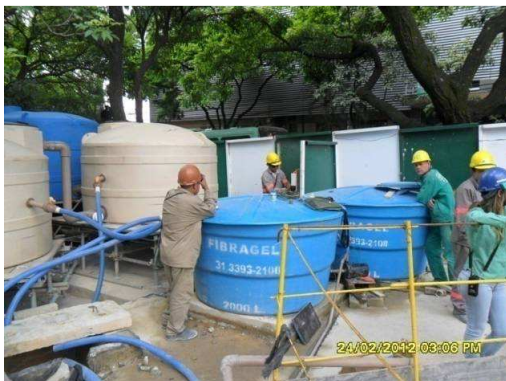
Efluente abaixo de 1ml/L utilizado no sistema de reuso do canteiro.
