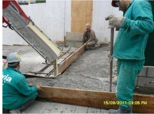
Relocação do lava rodas para área de carga e descarga situada entre a parede diafragma e a Av. Barbacena.
