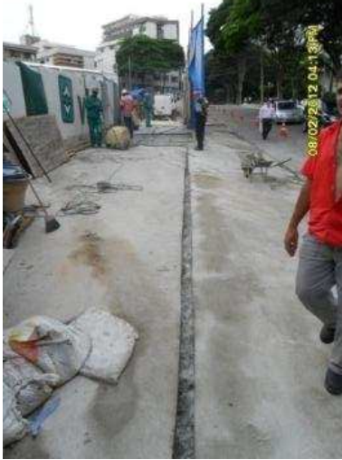
Execução de canaleta para direcionar sedimentos para a área interna do canteiro de obras.
