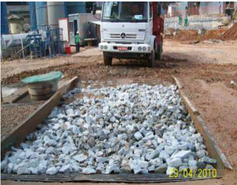
Utilização de pedra para retenção de sedimentos.
