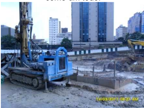
Atividade de Jet Grouting na área do lava rodas.
