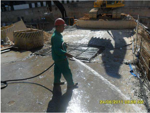
Limpeza da rampa por onde os veículos trafegam.
