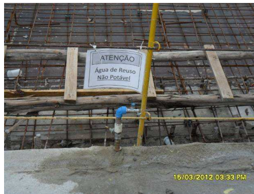
O sistema de reuso do canteiro abastece torneiras identificadas com finalidade de cura de concreto, limpeza, o próprio lava rodas e aspersão para controle de poeira.
