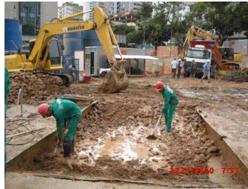
Limpeza da bacia metálica.
