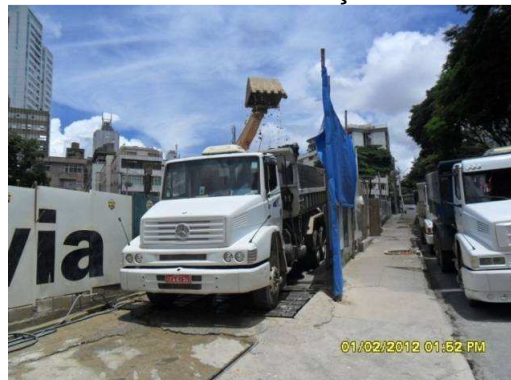
Proteção superior ao tapume para impedir respingos de sedimentos em via pública no ato do carregamento.
