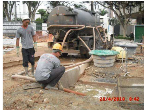
Limpeza com auxílio de caminhão limpa fossa para água reprovada em teste do Cone Imhoff.
