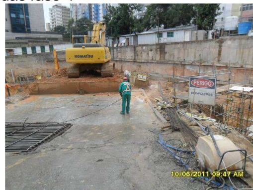
Plataforma para minimizar o contato dos veículos com solo exposto. Reduzindo a necessidade de limpar rodas e sim a limpeza da rampa.
