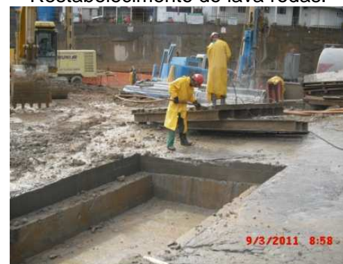
Limpeza da grelha do lava rodas e do sistema como um todo.
