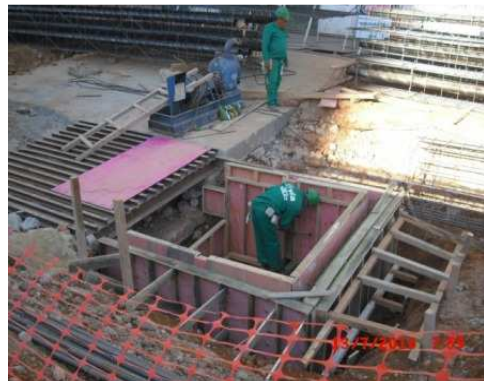
Execução das caixas de decantação em concreto.
