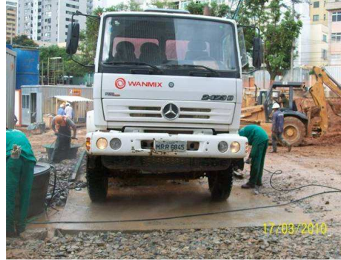
Detalhe do plano inclinado para escoamento.
