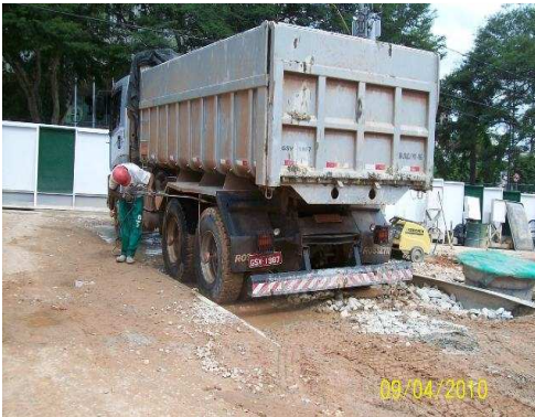
Operação do lava rodas com duas hidrolavadoras.
