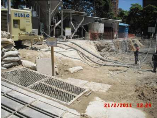
Instalação de caixa separadora de água e óleo.
