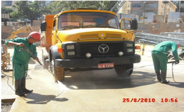
Detalhe das duas hidrolavadoras em uso.
