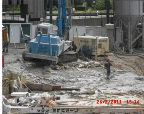
Atividade de Jet Grouting na área do lava rodas.
