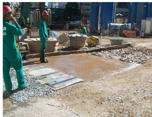
Vista geral do sistema de lava rodas.
