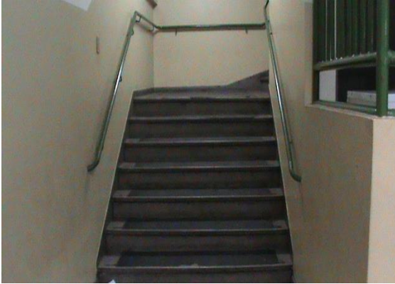
Foto 6 – Escada de acesso ao andar térreo
