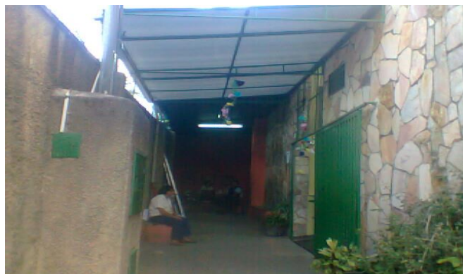
Foto 2 – Entrada principal – Vista de fora da instituição
