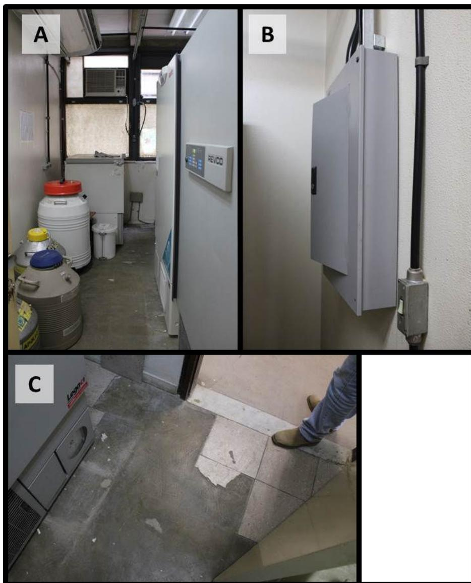
**FIGURA 8.** Sala de Freezers do DMVP. (A) Visão geral; (B) Quadro de energia elétrica; (C) Piso solto e desgastado.
