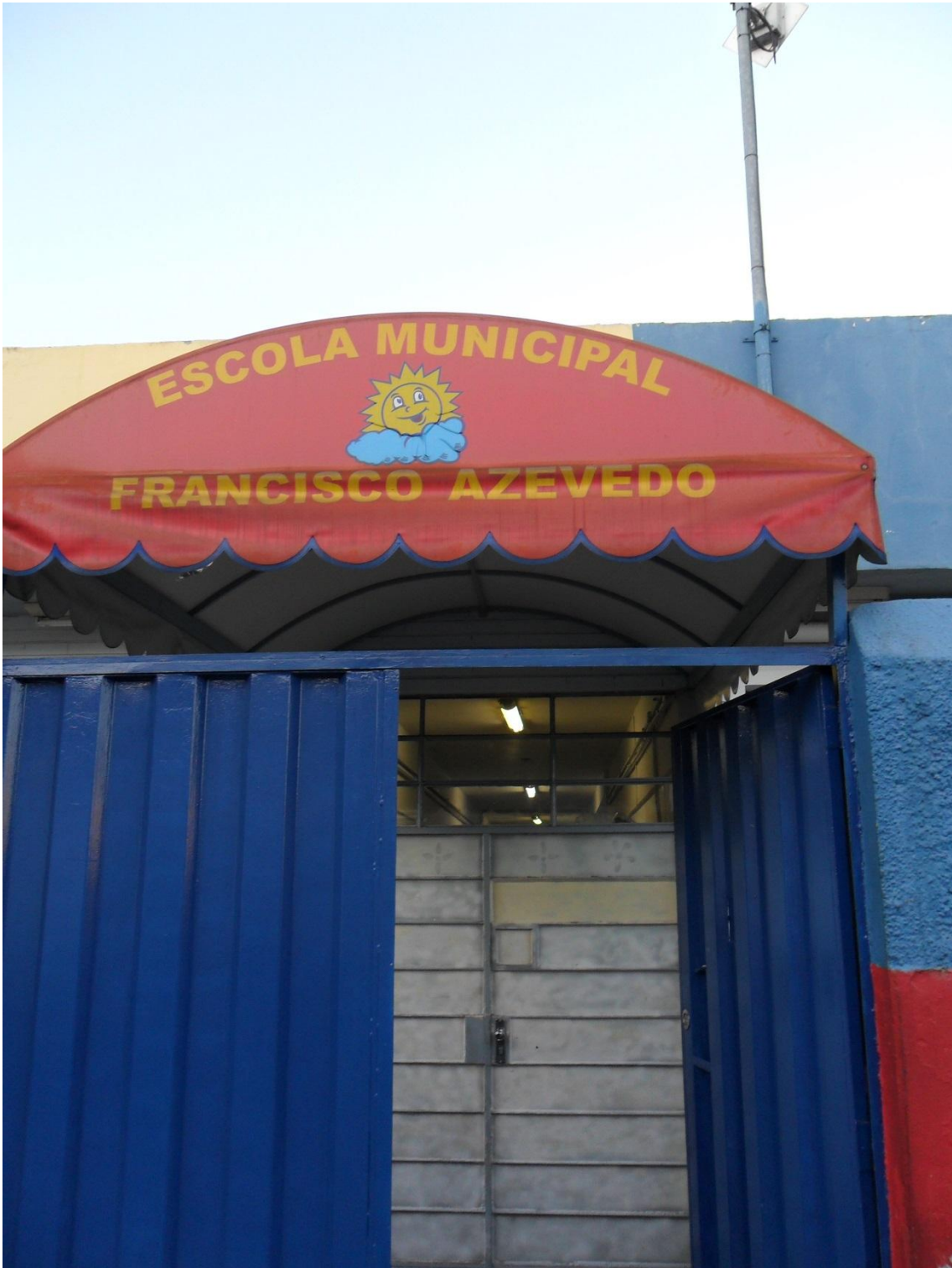
Figura 1: Portão de entrada da Escola Municipal Francisco Azevedo
