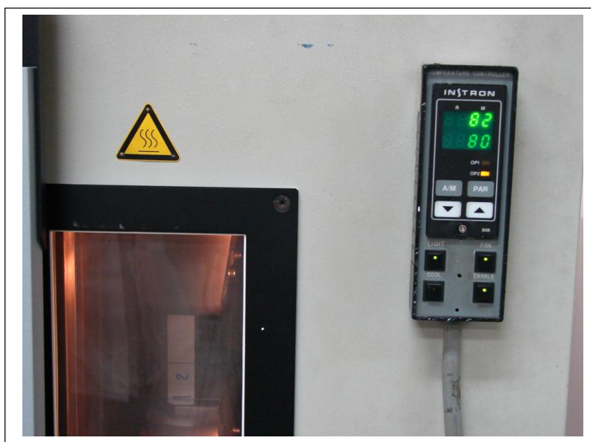
FIGURA 80 – Detalhe do controle de temperatura da estufa. FONTE – LAB.FIAT
