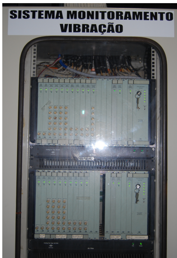
Figura 5.1: Módulos do sistema de monitoramento de vibrações da Usina de Emborcação.
